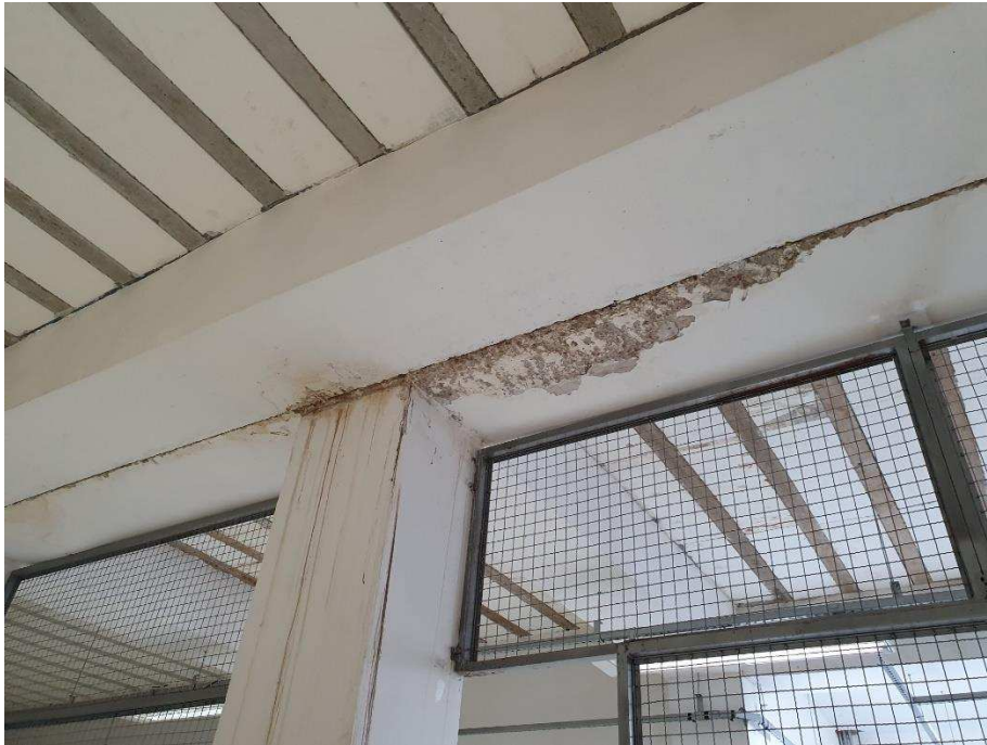
Imagem 7 - Junta de dilatação situação interna
