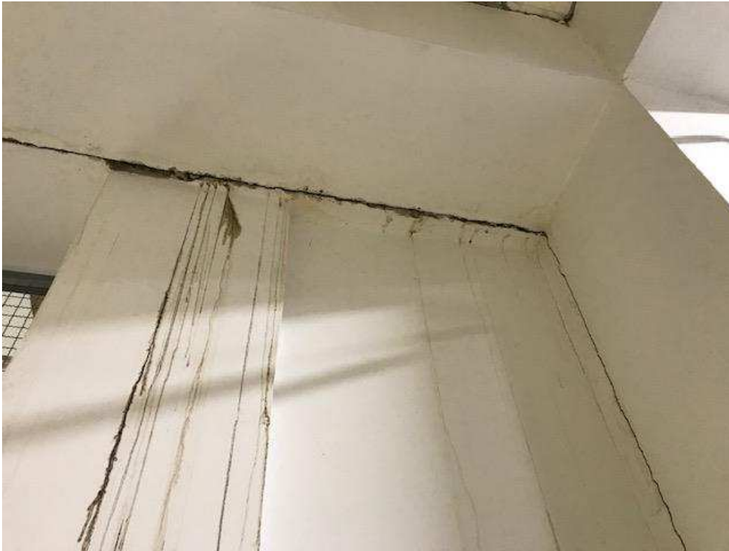
Imagem 9 - Junta de dilatação situação interna
