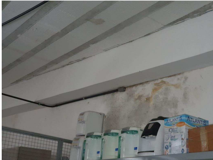
Imagem 20 – Sinais de infiltração em parede
