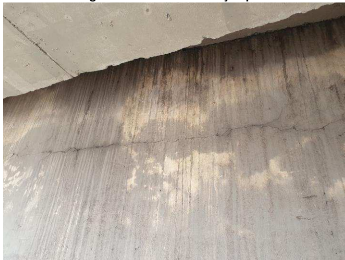
Imagem 22 – Junta de dilatação parede
