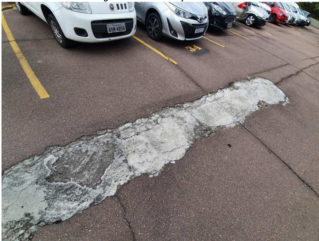
Imagem 6 - Junta de dilatação - Remendo
