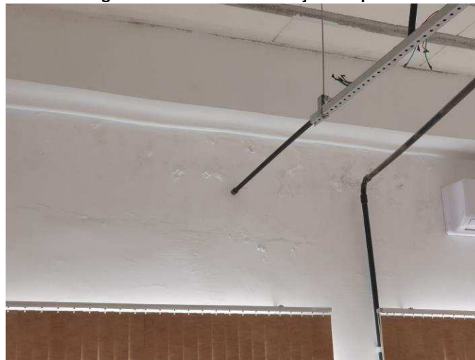
Imagem 21 – Sinais de infiltração em parede
