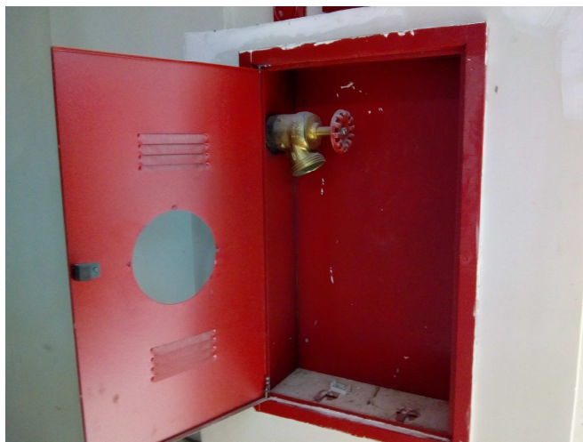
Imagem 39 - Abrigo de Hidrante
