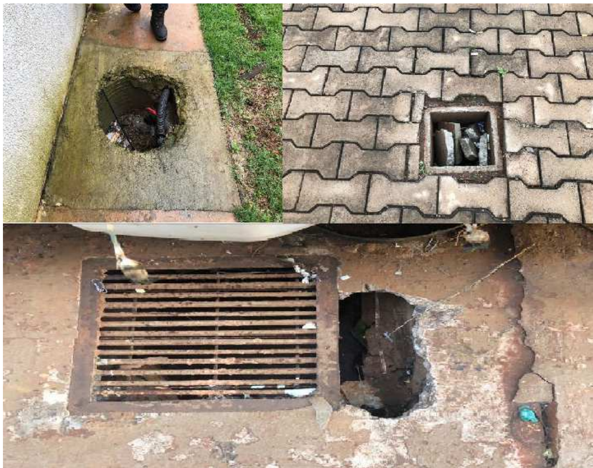
Imagem 28 - Caixas de passagem sem tampas e danificadas
