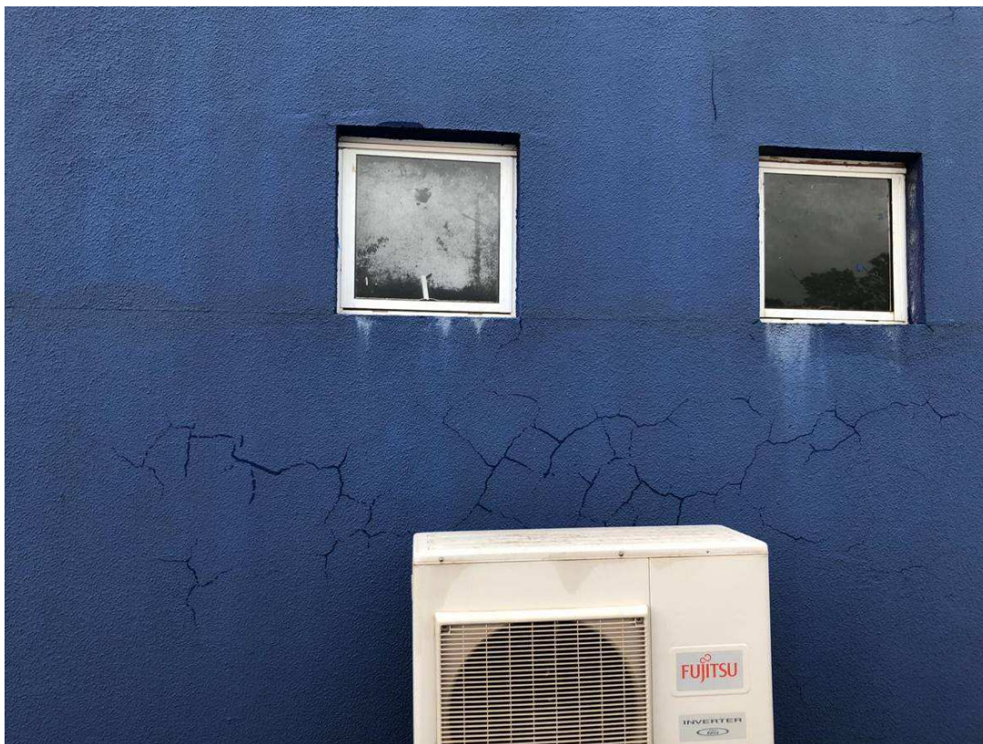
Imagem 22 - Janelas com infiltrações do Depósito de Urnas
