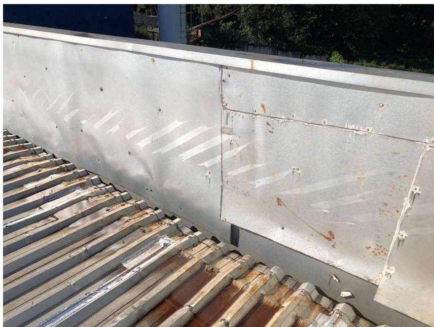
Imagem 14 - Chapas sobre as platibandas
