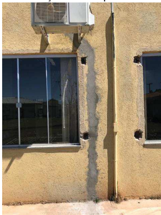
Imagem 34 – Execução de drenos parcialmente finalizada
