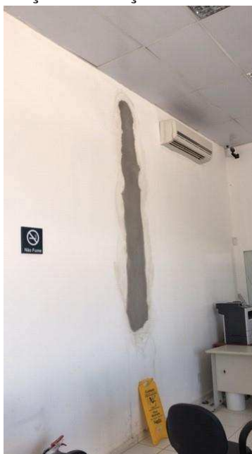
Imagem 10 – Serviço de correção de fissuras não finalizado
