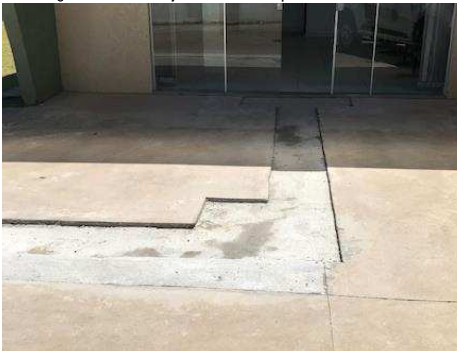
Imagem 1 - Corte da laje de concreto no pátio do Fórum Eleitoral
