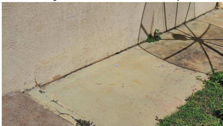
Imagem 36 – Paredes externas - recalque
