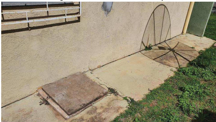
Imagem 37 – Paredes externas - recalque
