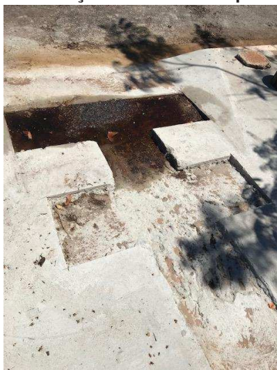
Imagem 3 – Execução e corte de rampa de concreto
