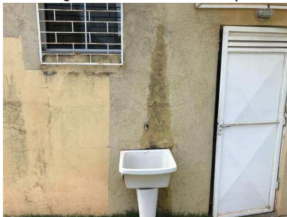
Imagem 33 – Vazamento no tanque
