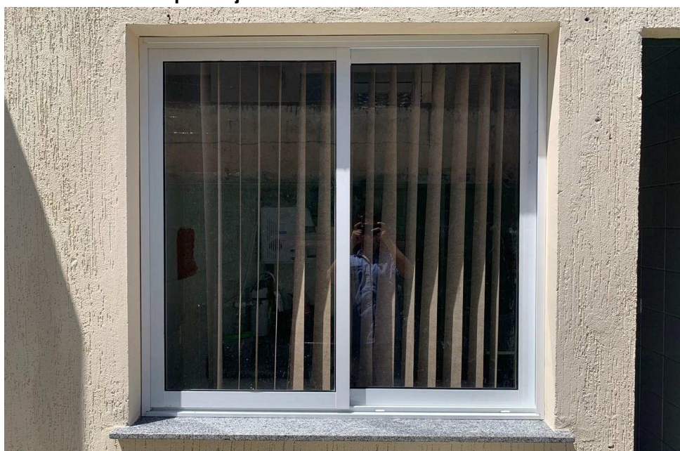
Exemplo de janela de alumínio com contramarco.
