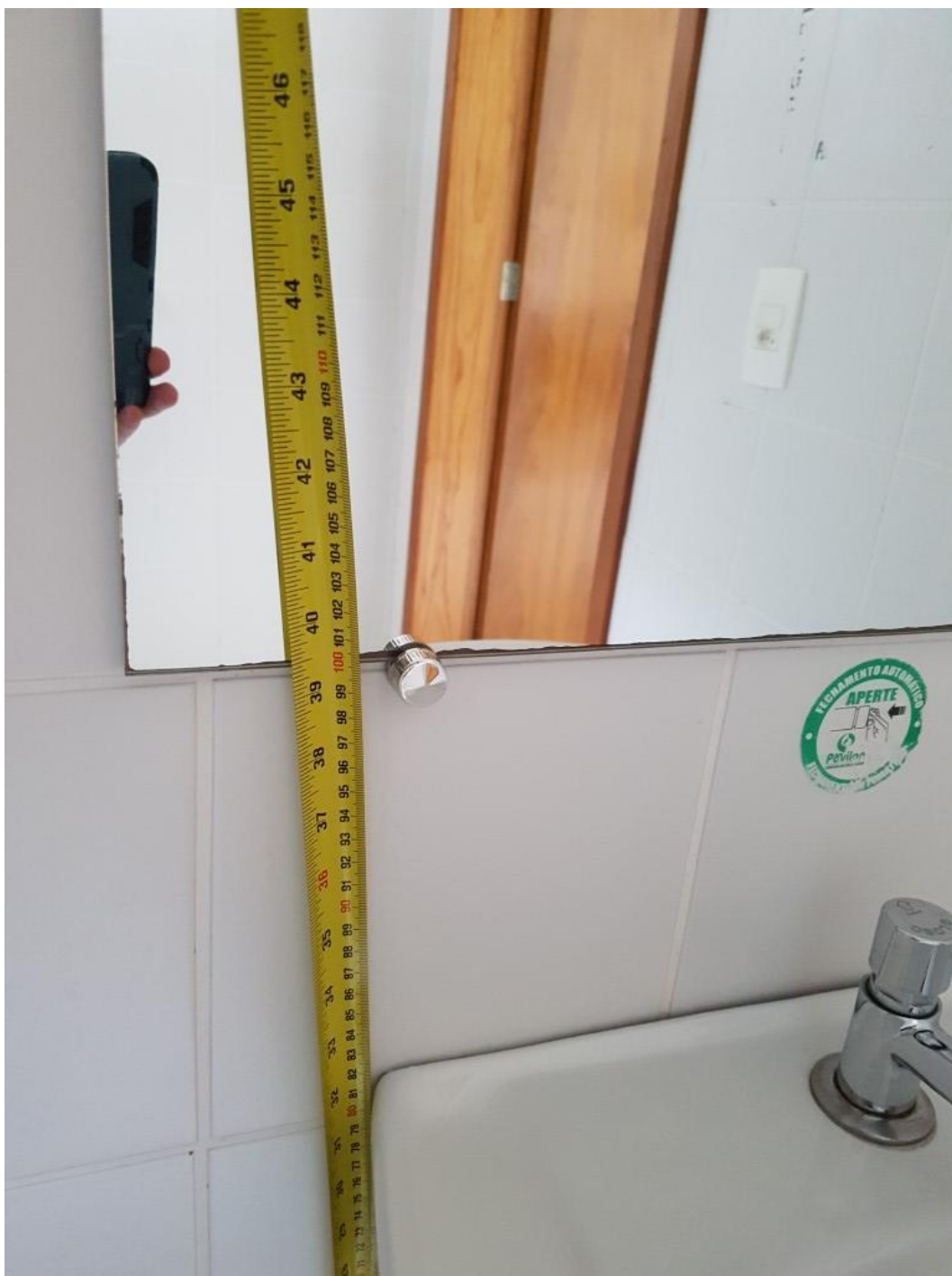
Altura e dimensão do espelho em desconformidade com a norma
