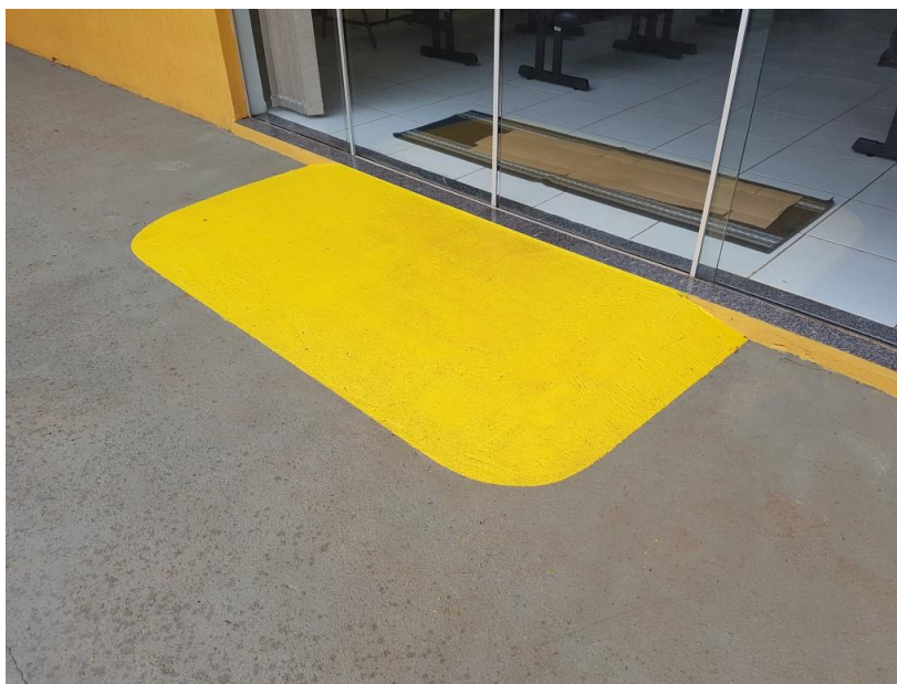
Nivelamento entre piso interno e externo
