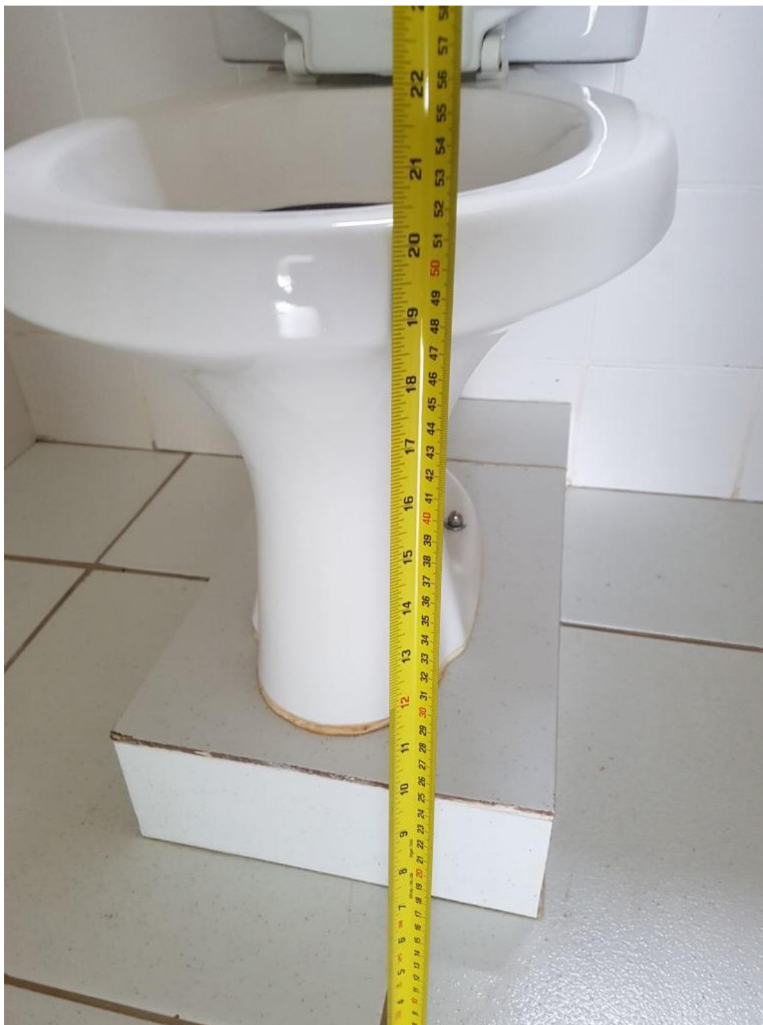
Altura e tipo do vaso sanitário em desconformidade com a norma
