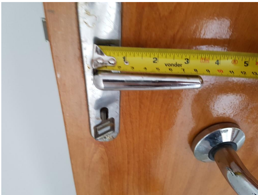
Fechadura em desconformidade com a norma
