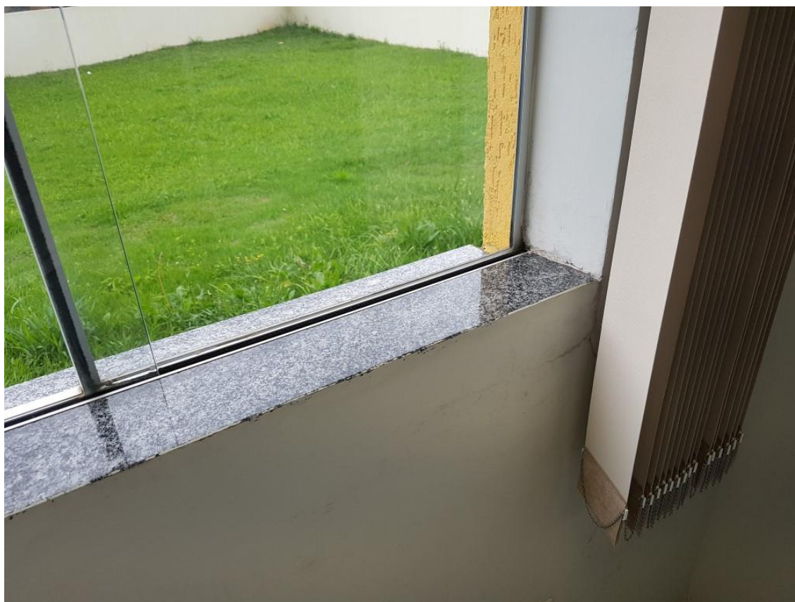
Infiltração pelo canto da esquadria
