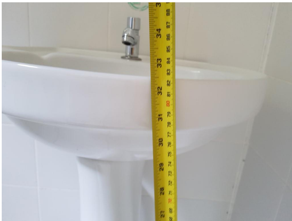
Altura e tipo do lavabo em desconformidade com a norma. Torneira idem.
