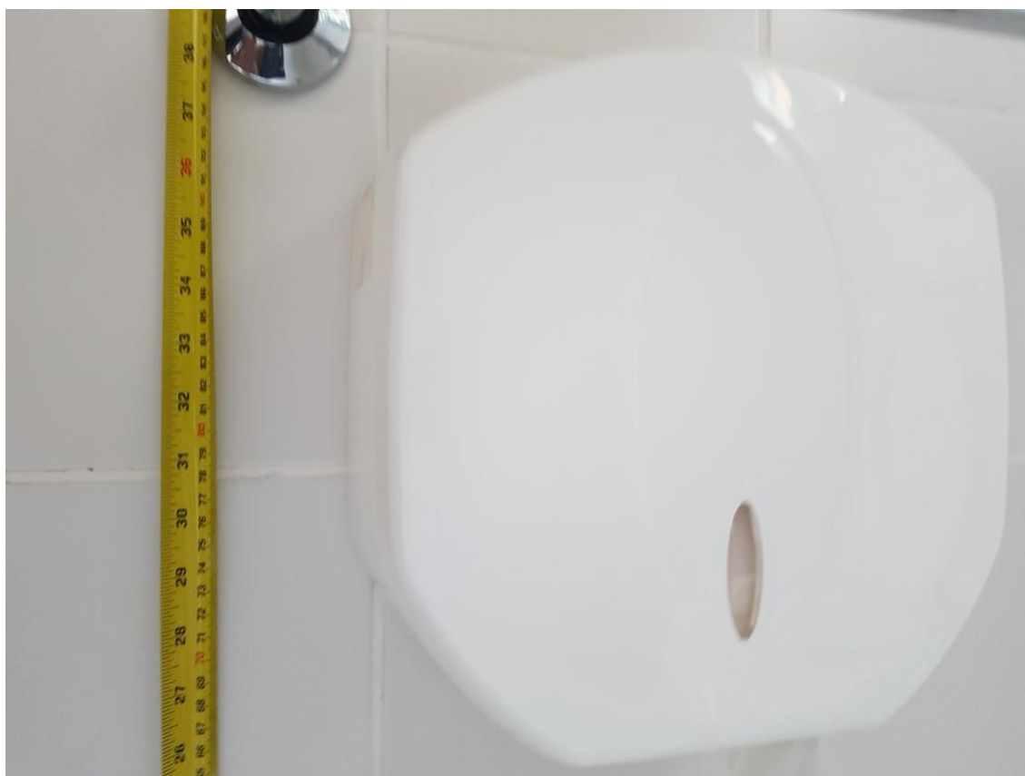
Altura da colocação da papeleira em desconformidade com a norma
