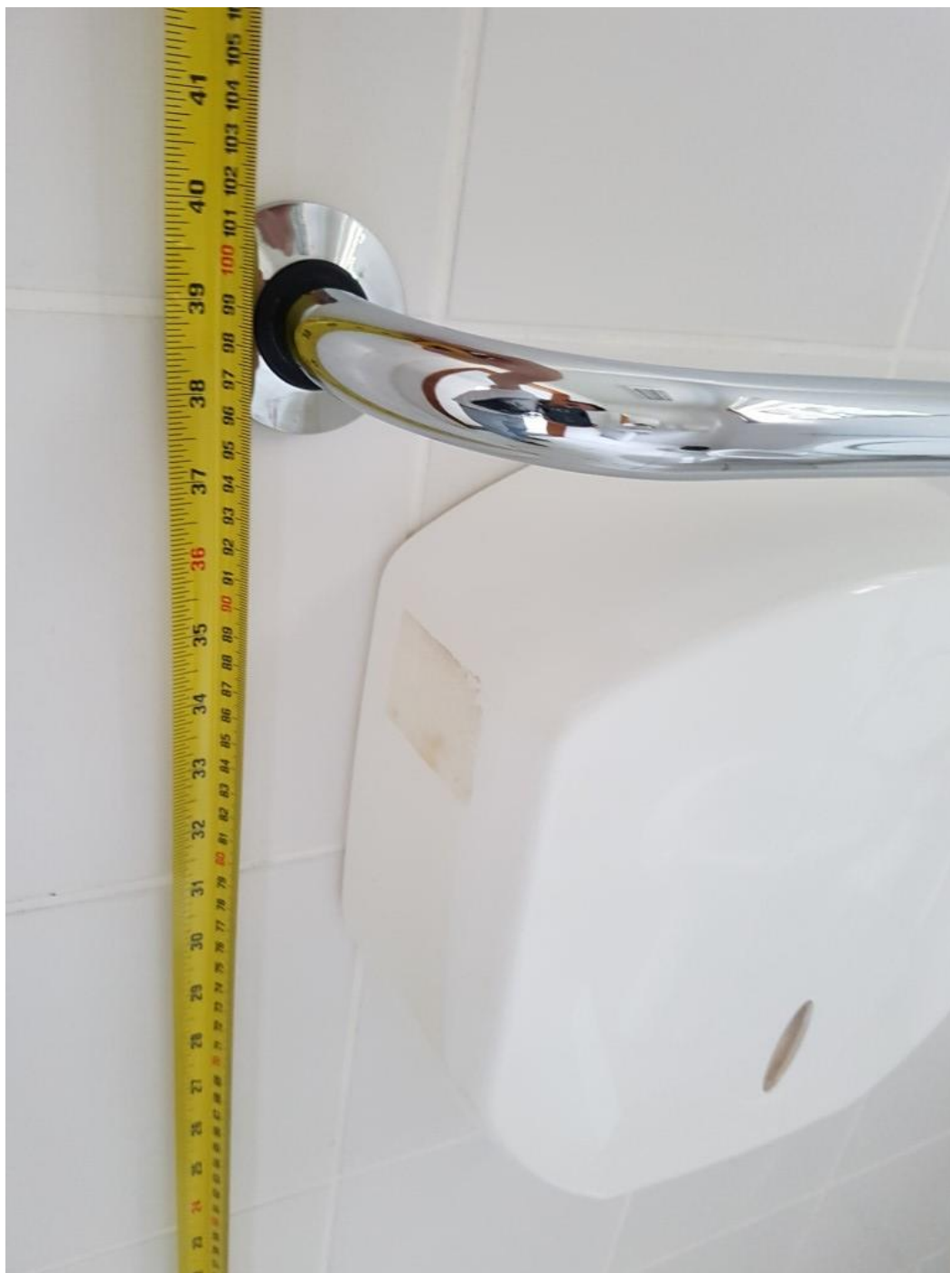
Altura de barra e diâmetro em desconformidade com a norma
