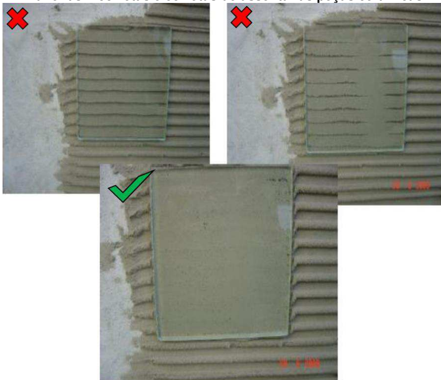
Maneiras incorretas e corretas de assentar as peças cerâmicas
