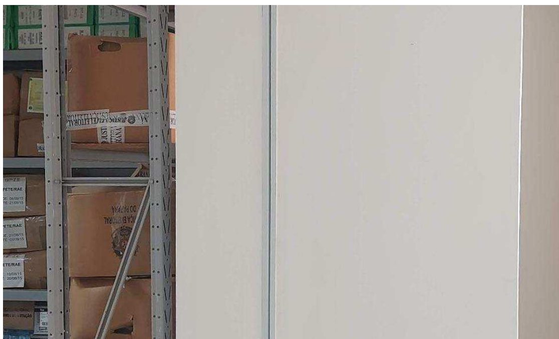
Detalhe da junta de movimentação já instalada no depósito de urnas
