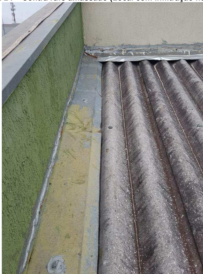
Imagem 24 – Contra rufo amassado (Local com infiltração no Fórum)
