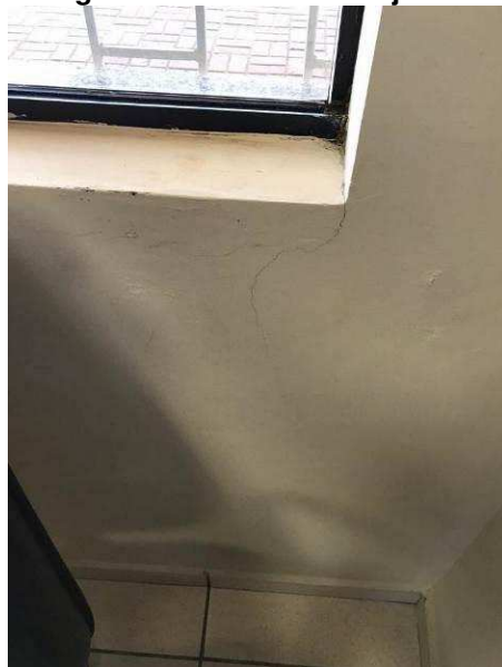
Imagem 20 – Fissuras em janelas
