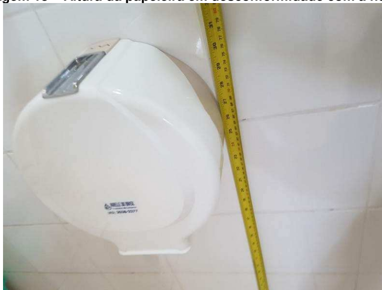
Imagem 13 – Altura da papelreira em desconformidade com a norma
