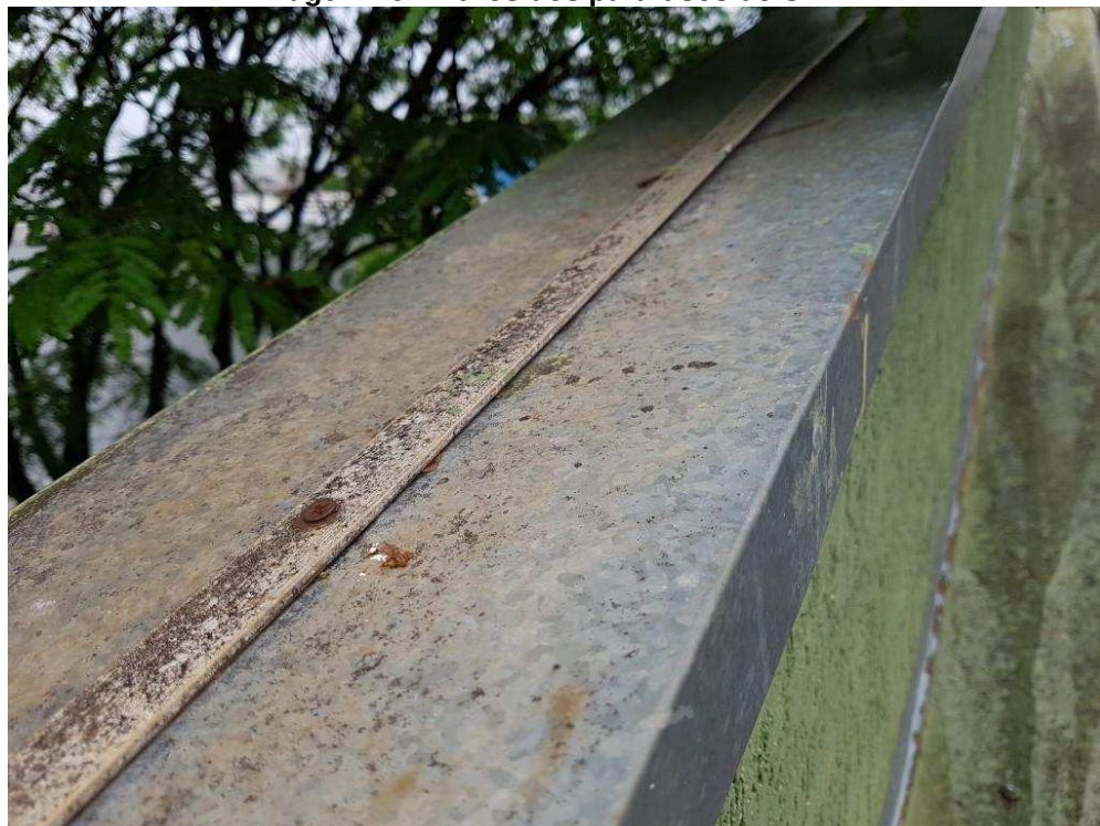
Imagem 25 – Furos dos parafusos do SPDA
