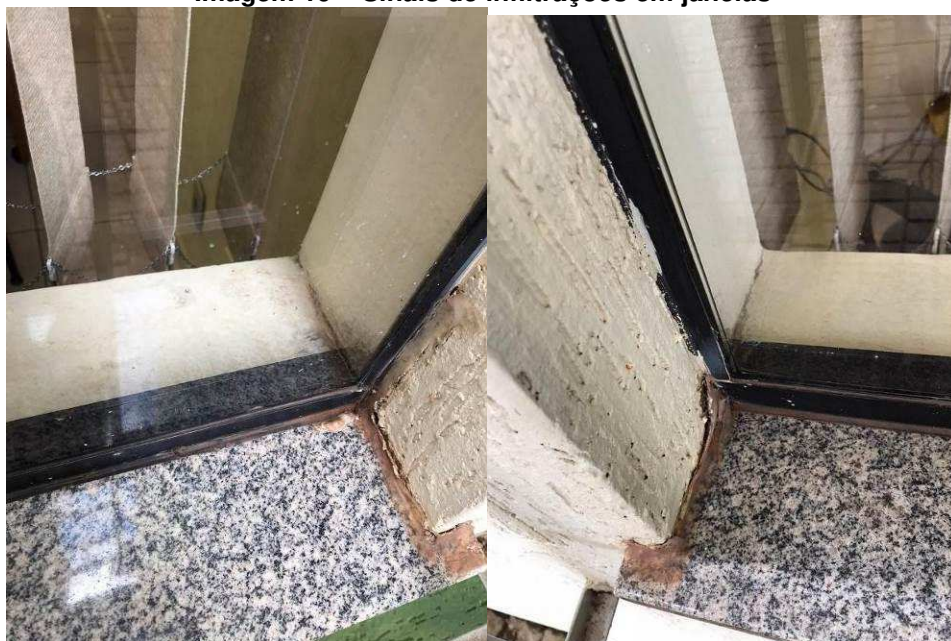
Imagem 19 – Sinais de infiltrações em janelas
