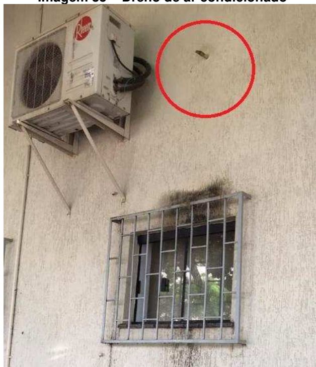
Imagem 35 – Dreno de ar condicionado
