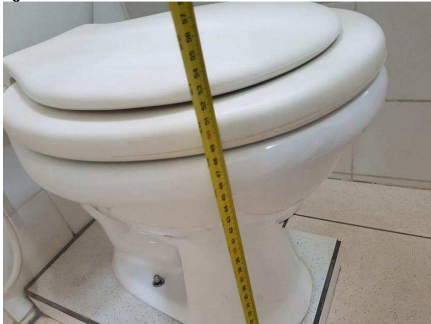
Imagem 9 – Altura do vaso sanitário em desconformidade com a norma
