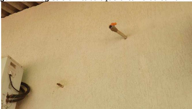
Imagem 49 – Registro em tubulação externa da caixa d'água.
