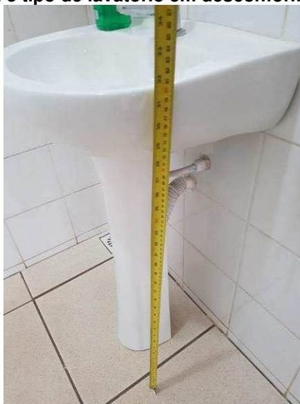
Imagem 14 – Altura e tipo de lavatório em desconformidade com a norma
