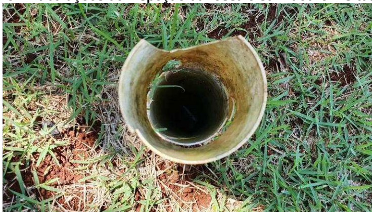
Imagem 48 – Tubulações de inspeção da fossa e sumidouro – Situação atual
