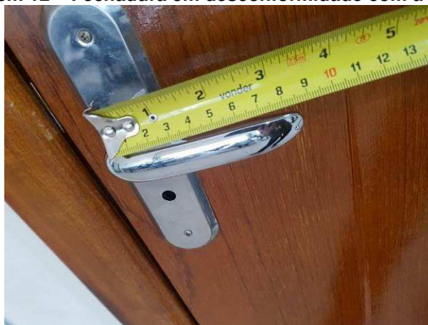
Imagem 12 – Fechadura em desconformidade com a norma
