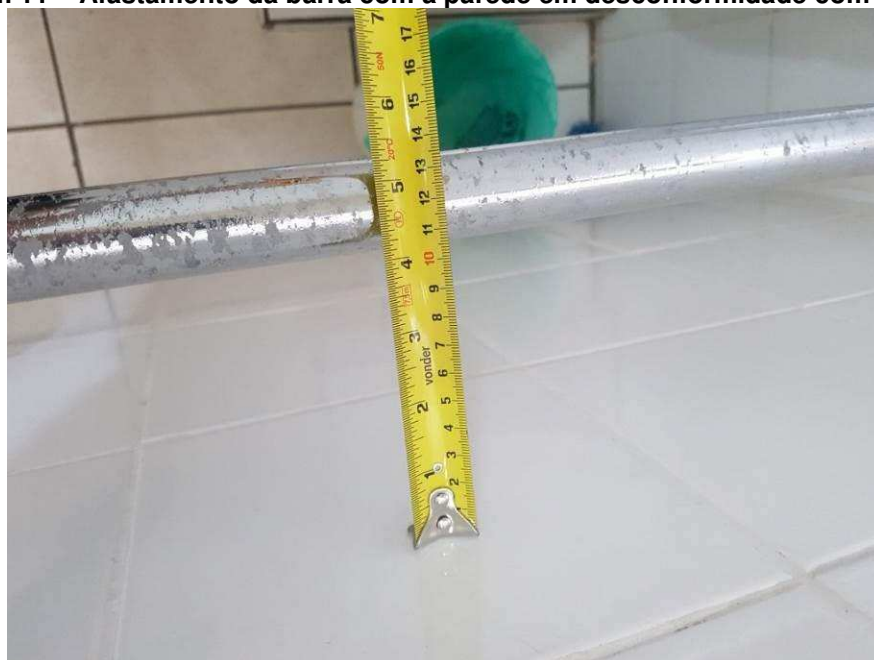
Imagem 11 – Afastamento da barra com a parede em desconformidade com a norma
