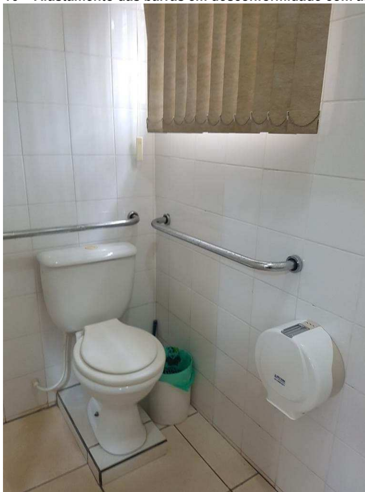
Imagem 10 – Afastamento das barras em desconformidade com as normas
