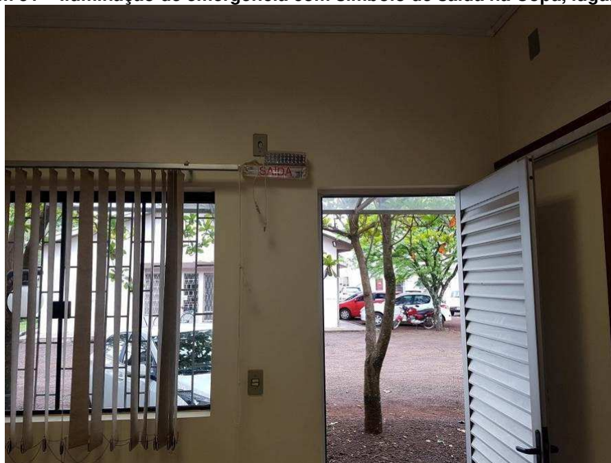
Imagem 51 – Iluminação de emergência com símbolo de saída na Copa, lugar errado
