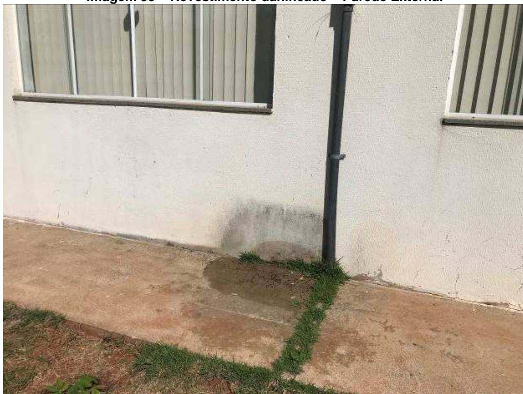
Imagem 53 – Revestimento danificado – Parede Externa.
