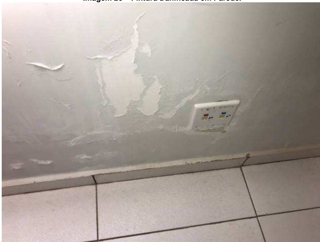
Imagem 26 – Pintura Danificada em Parede.
