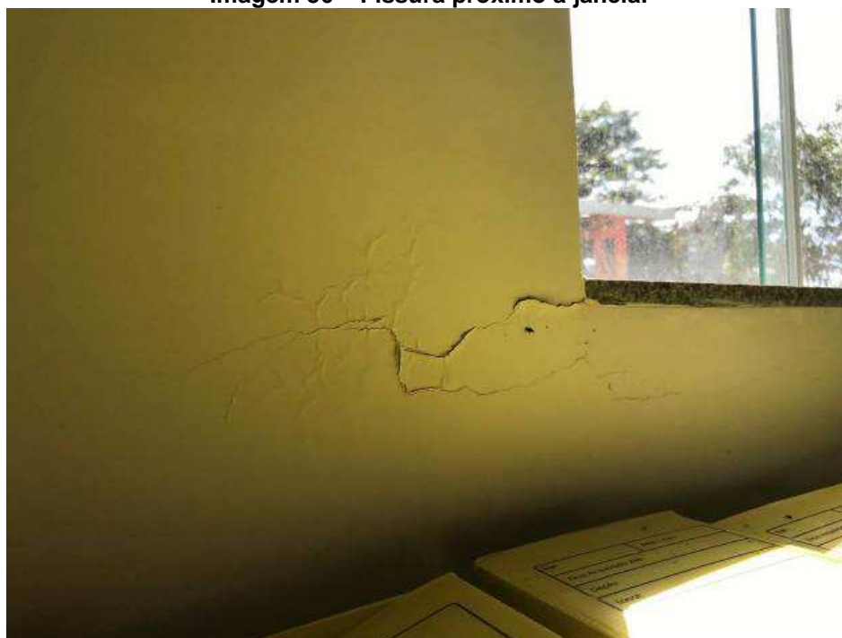
Imagem 36 – Fissura próximo à janela.
