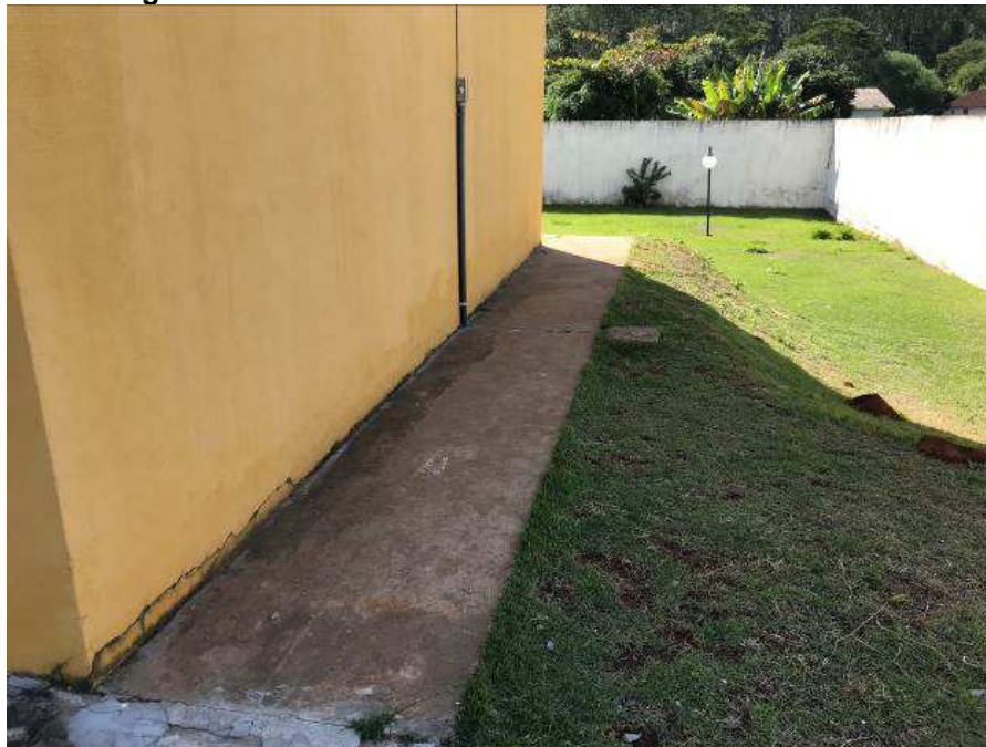
Imagem 55 – Parede externa com revestimento danificado.
