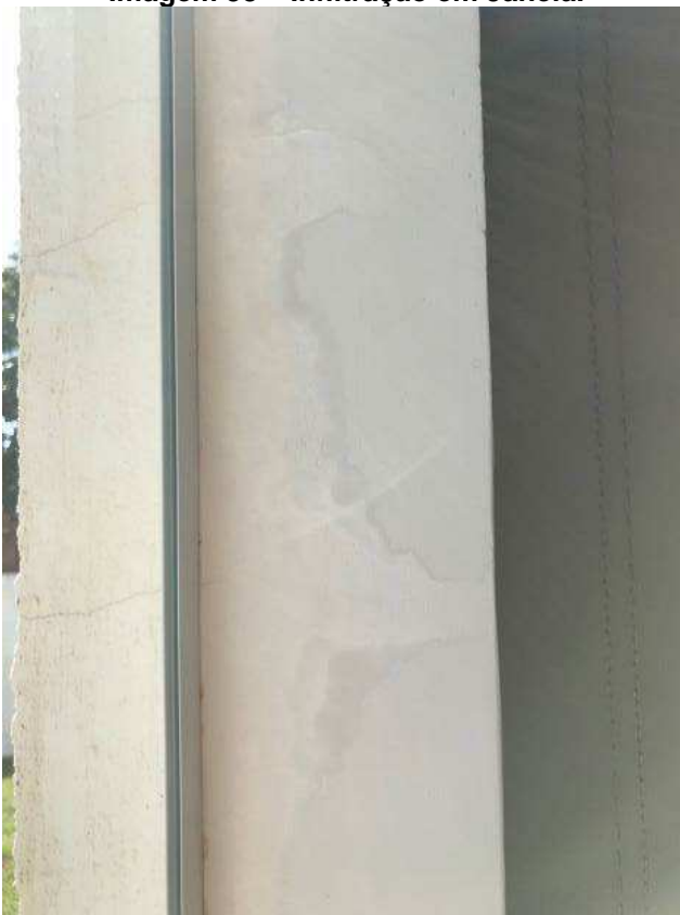
Imagem 38 – Infiltração em Janela.
