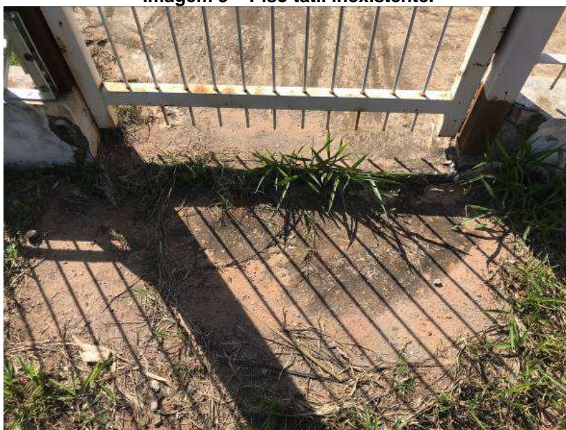
Imagem 3 – Piso tátil inexistente.
