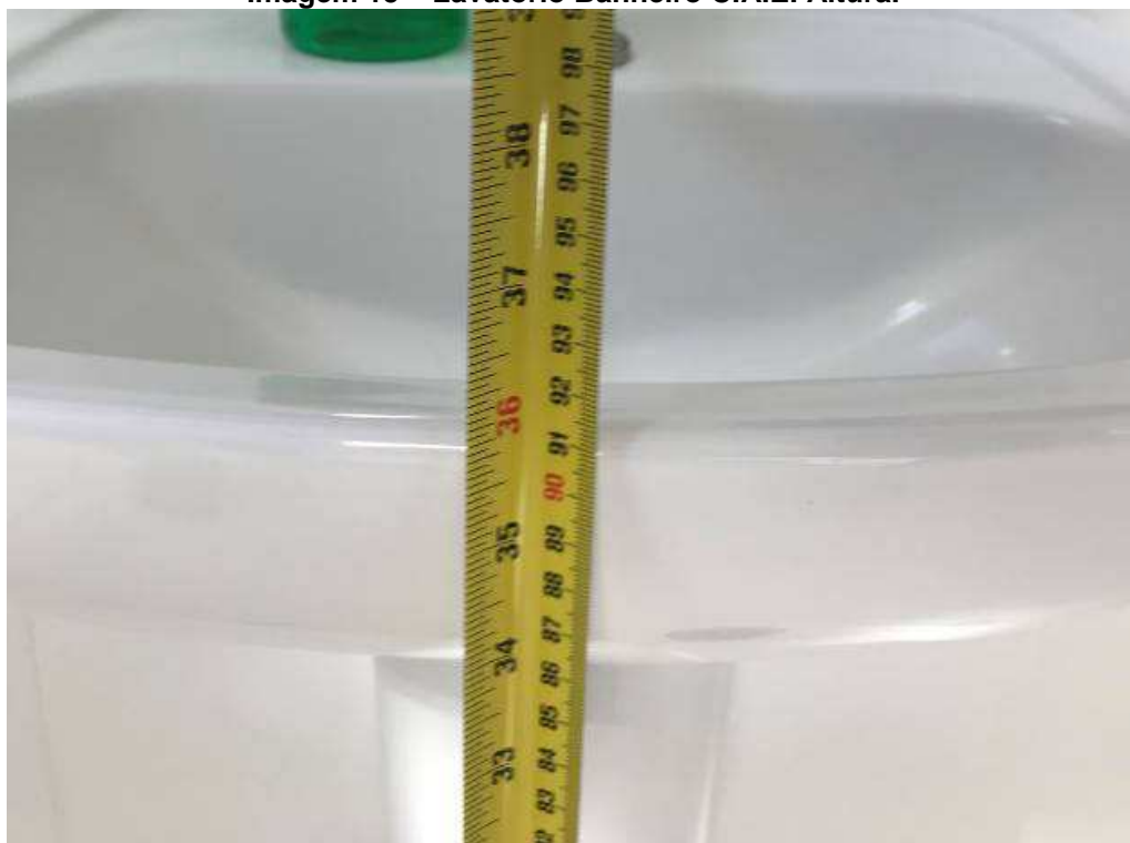
Imagem 15 – Lavatório Banheiro C.A.E. Altura.
