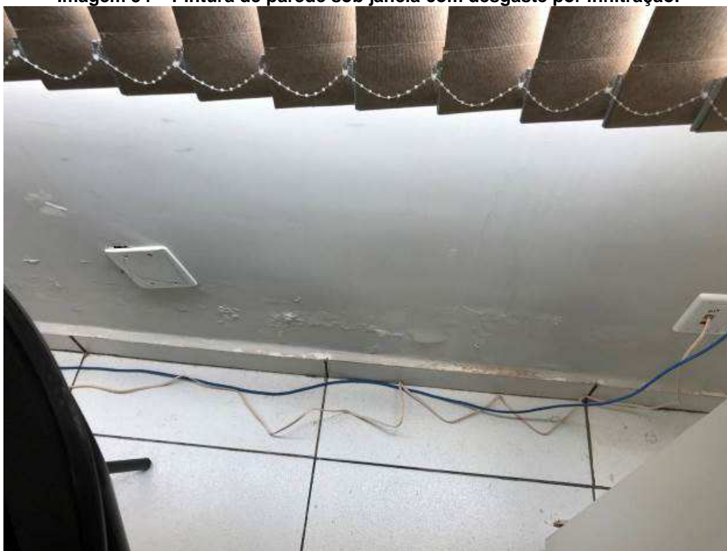
Imagem 34 – Pintura de parede sob janela com desgaste por infiltração.
