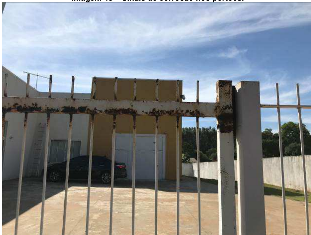
Imagem 43 – Sinais de corrosão nos portões.
