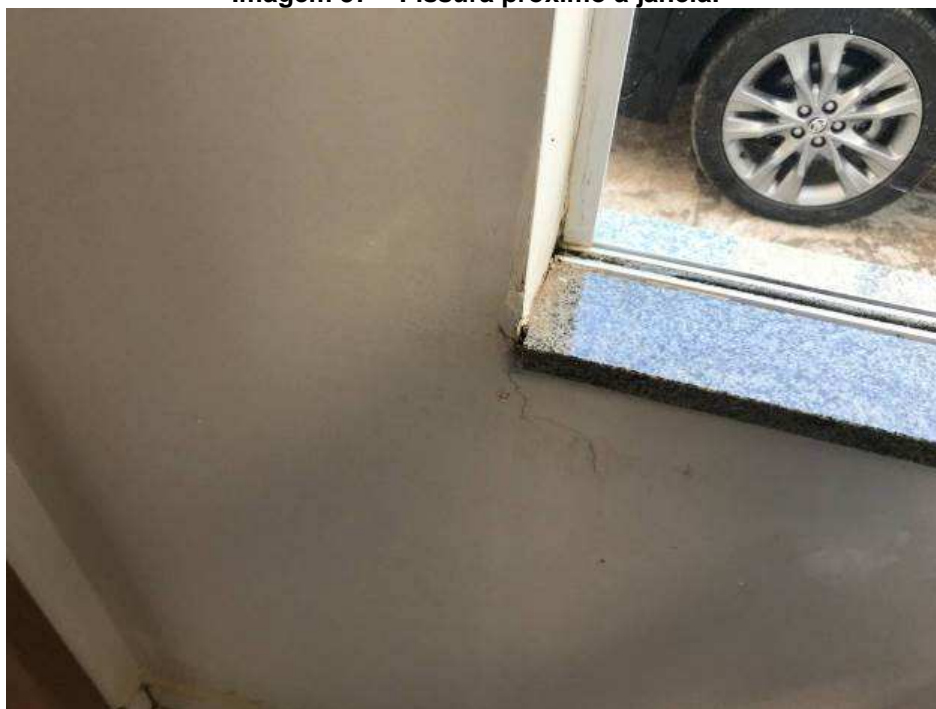
Imagem 37 – Fissura próximo à janela.
