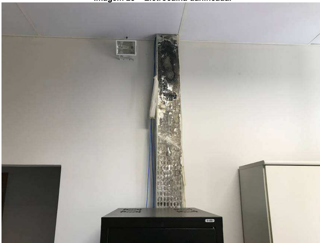
Imagem 25 – Eletrocalha danificada.
