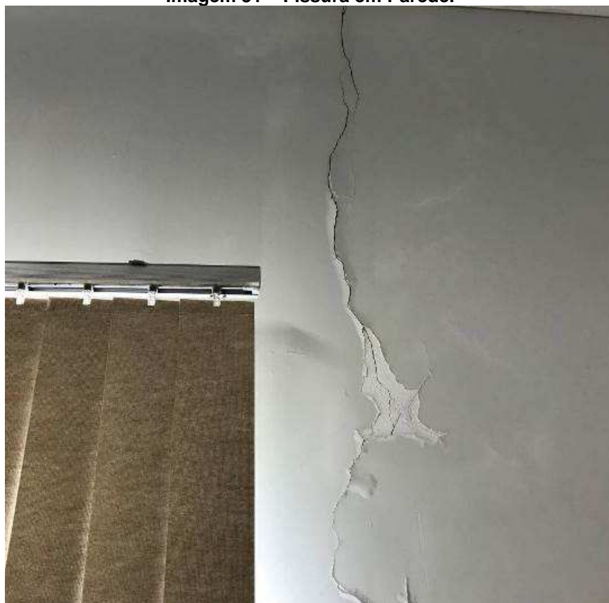
Imagem 31 – Fissura em Parede.
