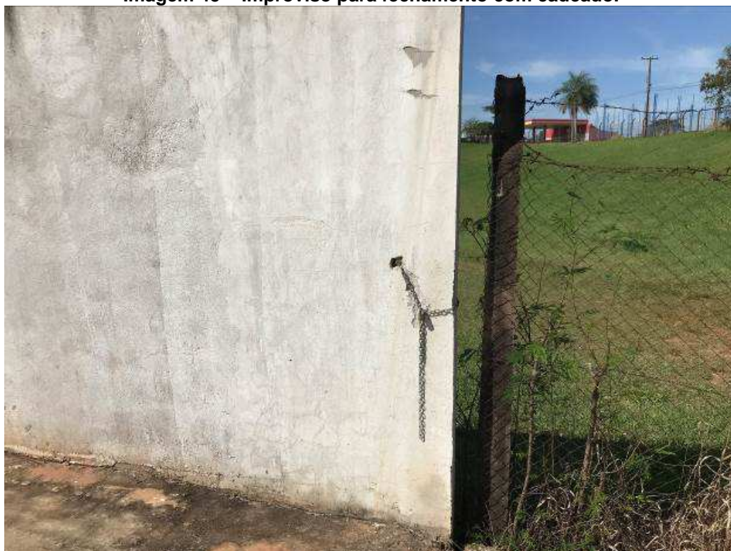
Imagem 45 – Improviso para fechamento com cadeado.
