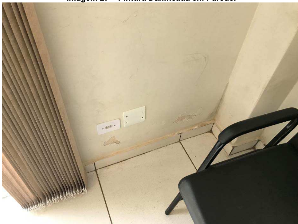
Imagem 27 – Pintura Danificada em Parede.
