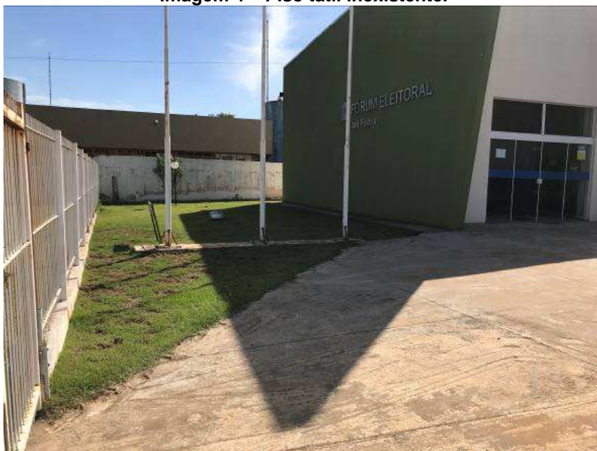
Imagem 4 – Piso tátil inexistente.
