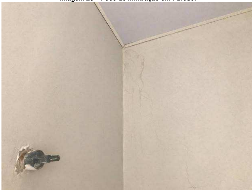
Imagem 28 – Foco de Infiltração em Parede.
