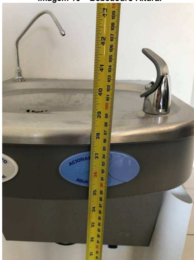
Imagem 10 – Bebedouro Altura.
