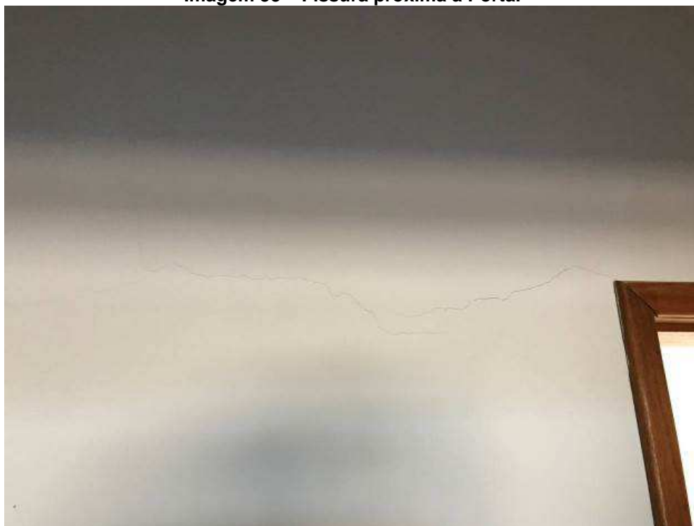
Imagem 33 – Fissura próxima à Porta.
