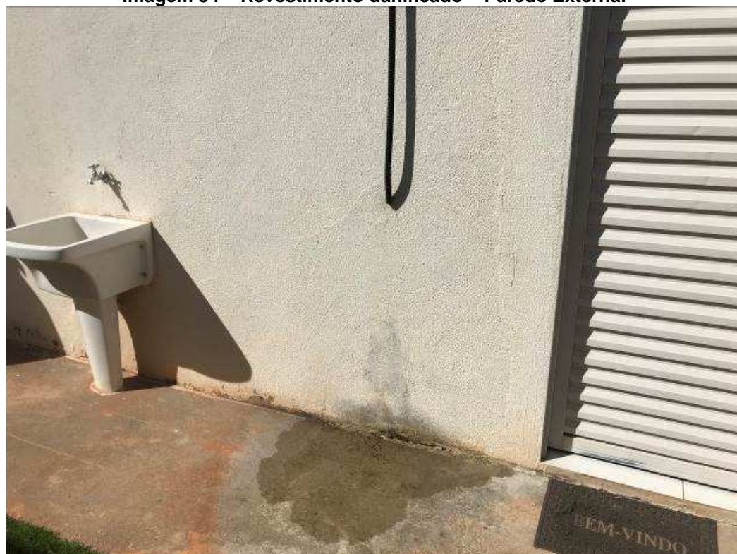
Imagem 54 – Revestimento danificado – Parede Externa.
