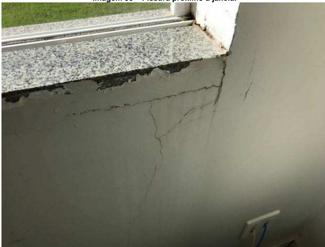
Imagem 35 – Fissura próximo à janela.
