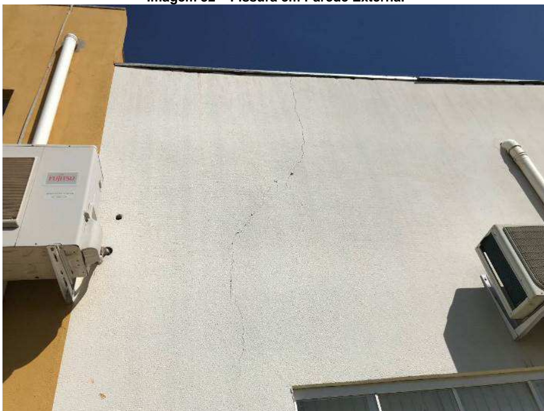
Imagem 32 – Fissura em Parede Externa.
