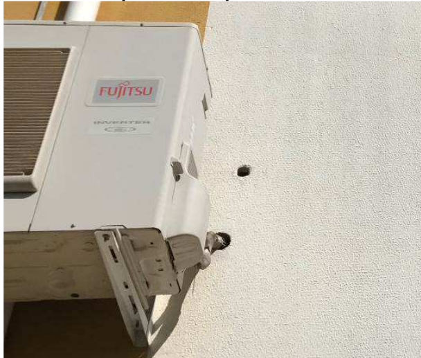
Imagem 56 – Furo próximo a aparelho de ar-condicionado.
