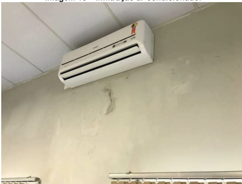
Imagem 18 – Infiltração ar-condicionado.
