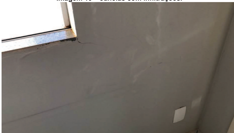
Imagem 19 – Janelas com infiltrações.
