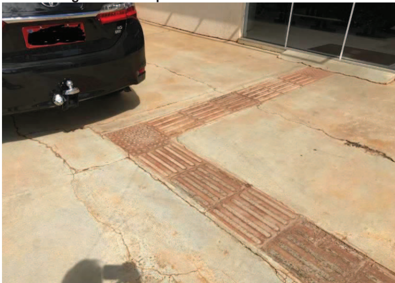
Imagem 4 – Piso podotátil e desnível de entrada.
