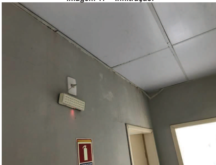
Imagem 17 – Infiltração.
