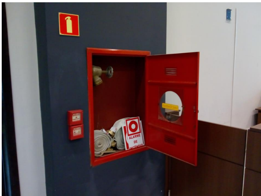
Foto 2 - Abrigo de Hidrante - Sede TRE - Sem Visor, em shaft de alvenaria
