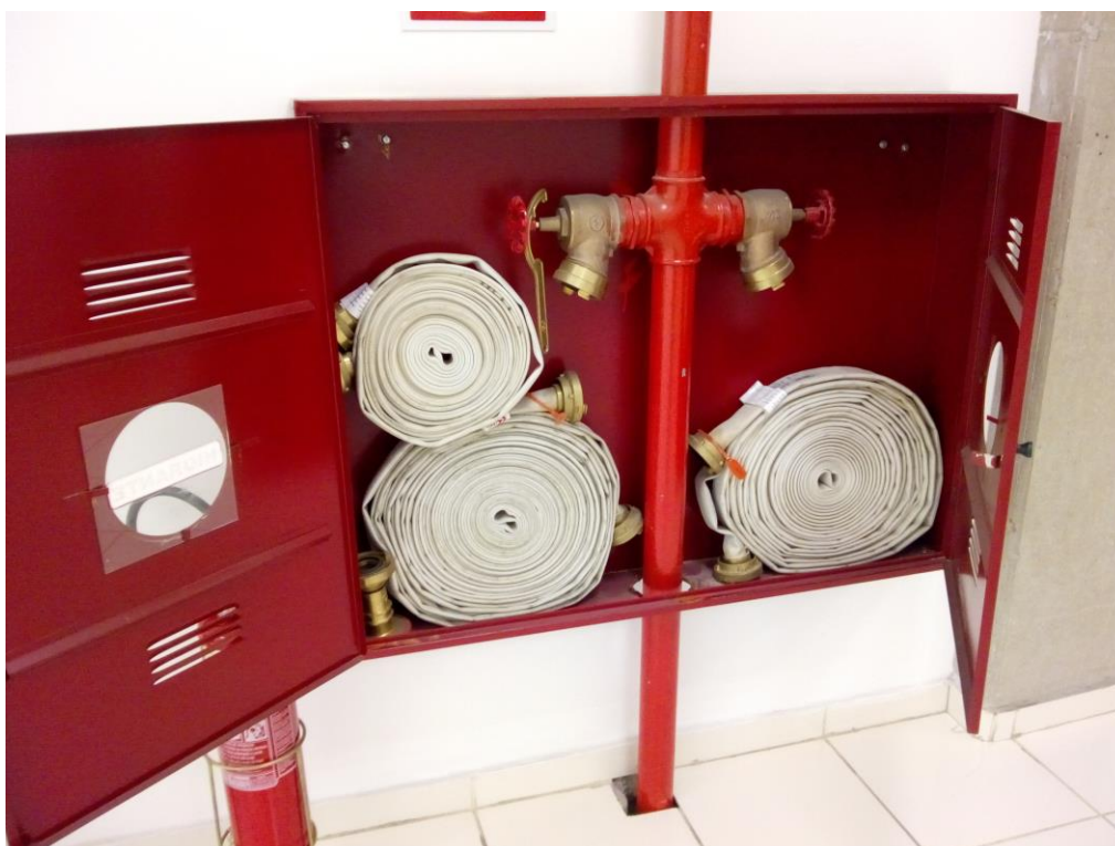
Foto 4 - Abrigo de Hidrante Duplo - Fórum Curitiba
