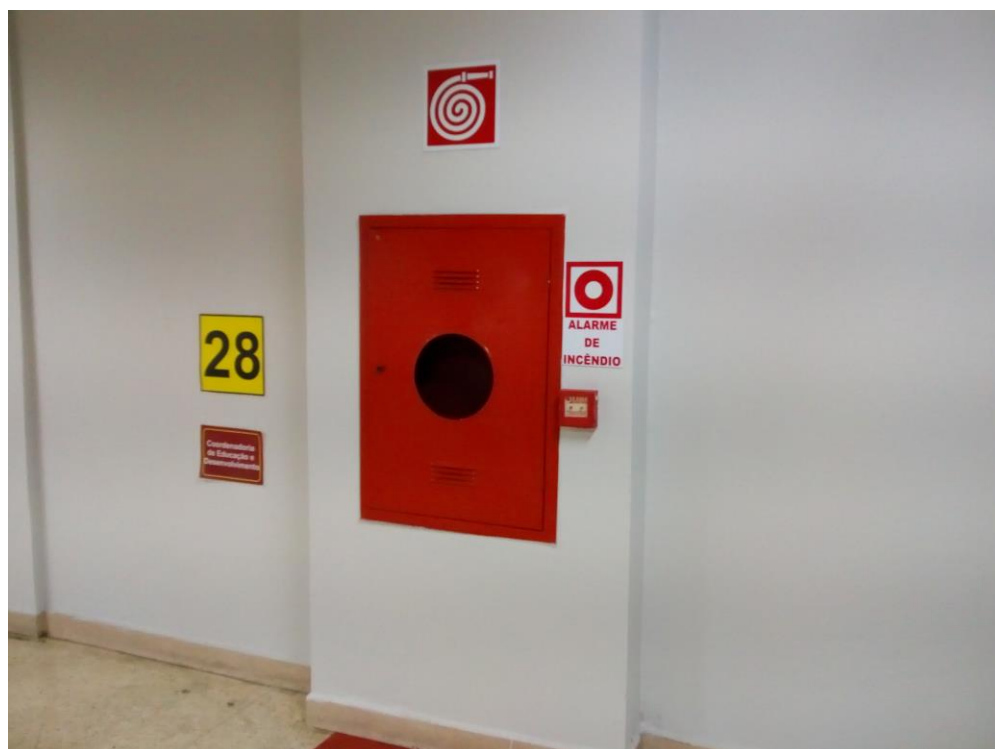
Foto 2 - Abrigo de Hidrante - Sede TRE - Sem Visor, em shaft de alvenaria
