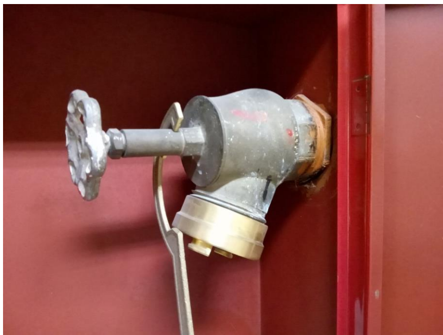
Foto 8 - Abrigo de Hidrante - Sede TRE - Com Shaft em DryWall
