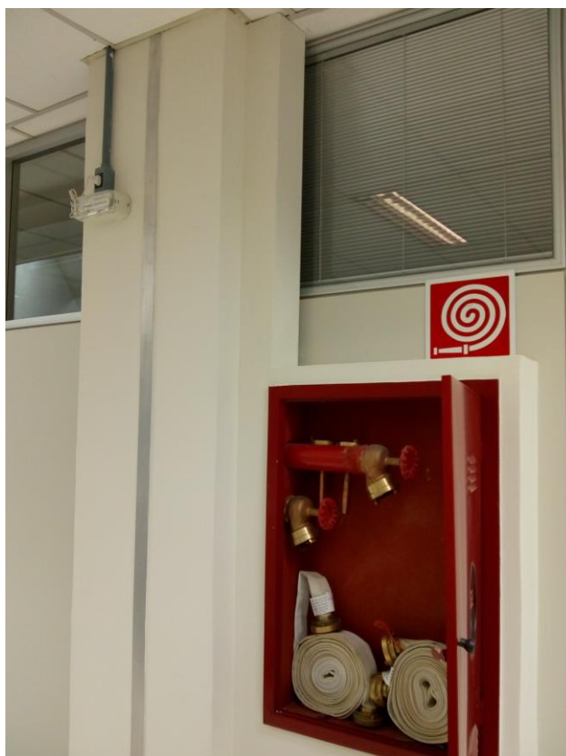
Foto 8 - Abrigo de Hidrante - Sede TRE - Com Shaft em DryWall
