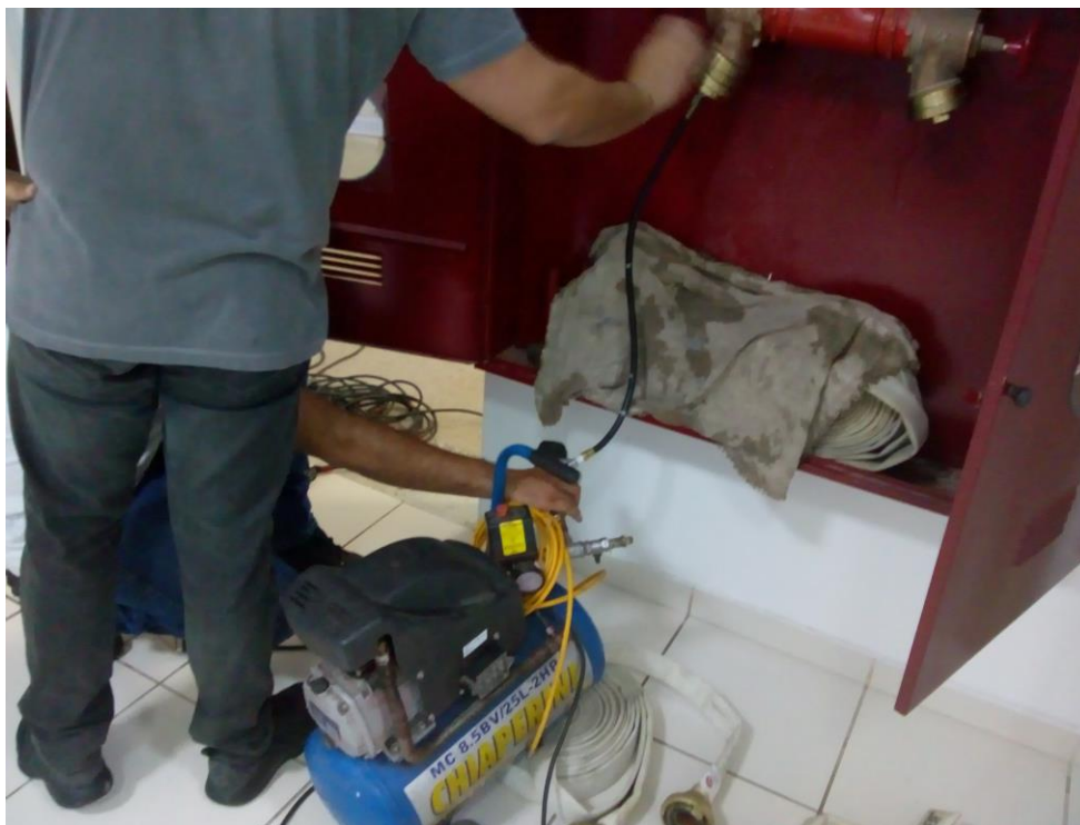
Imagem 2 - Teste de estanqueidade pneumático
