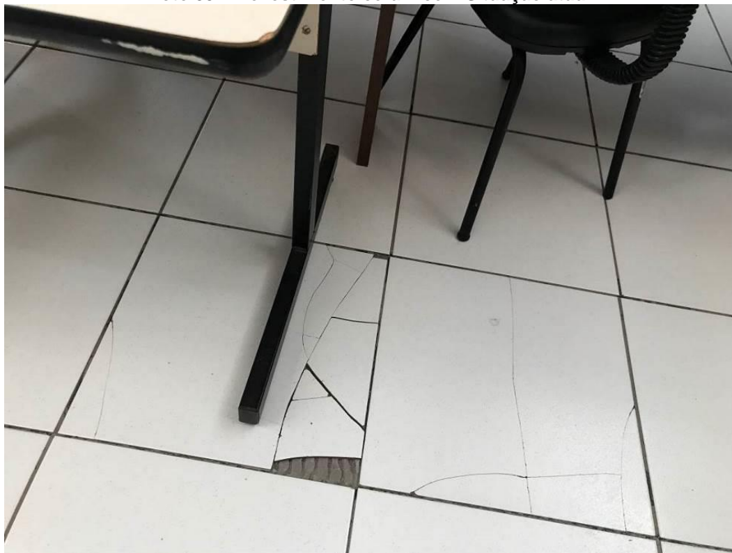
Foto 39 – Revestimento cerâmico – Situação atual.
