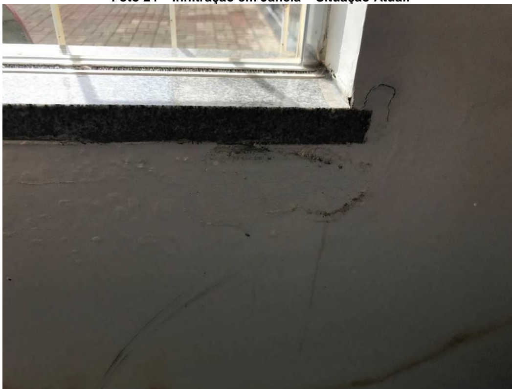
Foto 24 – Infiltração em Janela – Situação Atual.
