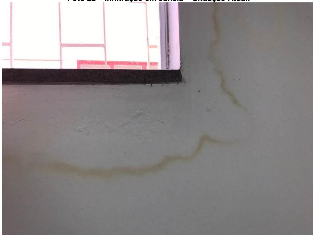
Foto 22 – Infiltração em Janela – Situação Atual.
