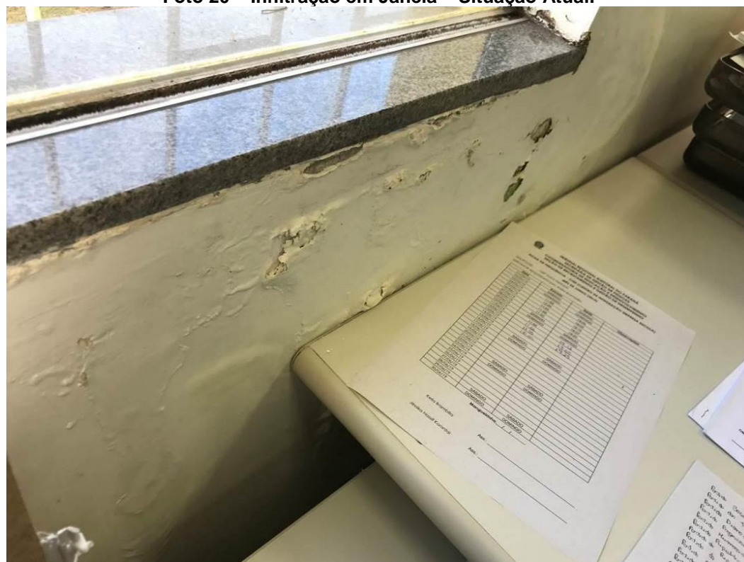
Foto 20 – Infiltração em Janela – Situação Atual.
