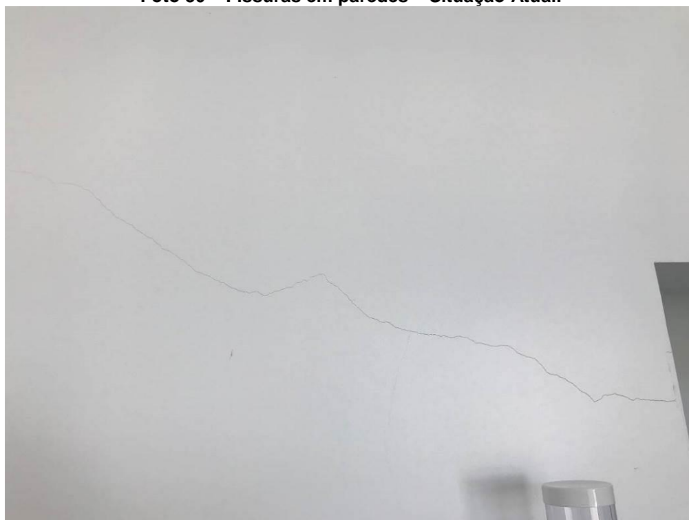
Foto 30 – Fissuras em paredes – Situação Atual.
