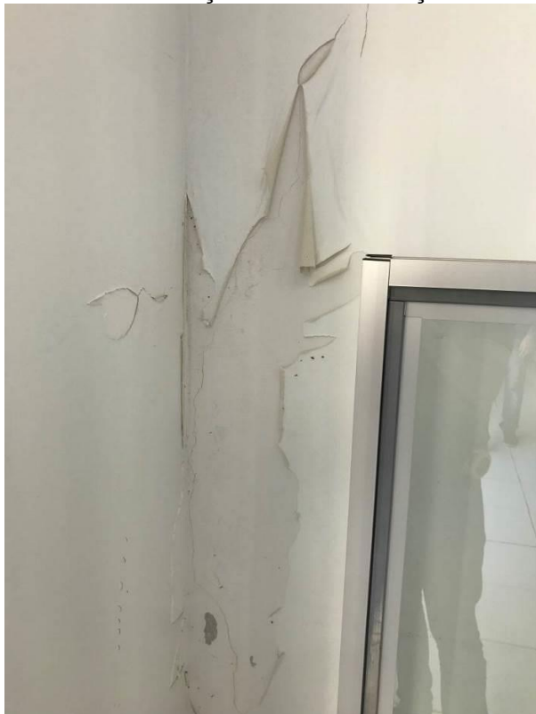
Foto 27 – Infiltração Parede – Situação Atual.
