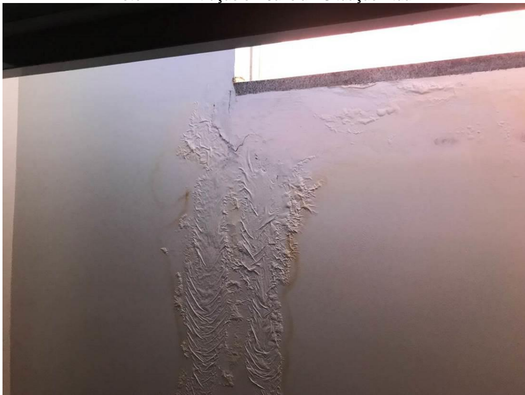
Foto 21 – Infiltração em Janela – Situação Atual.
