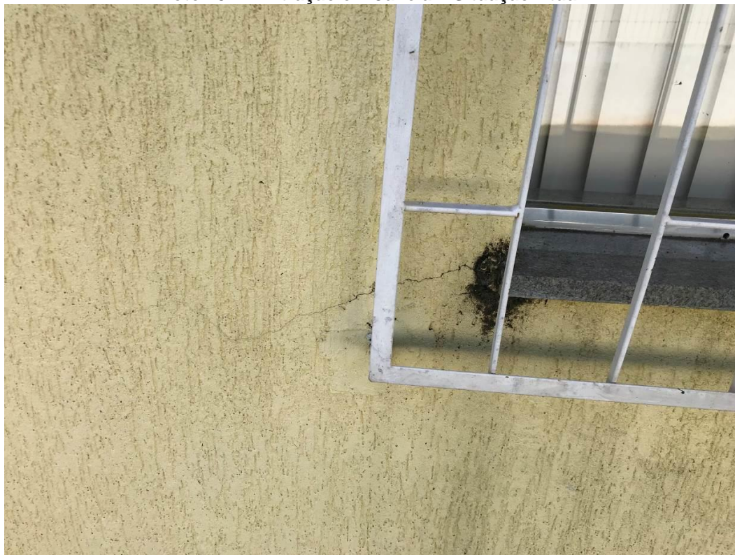
Foto 19 – Infiltração em Janela – Situação Atual.
