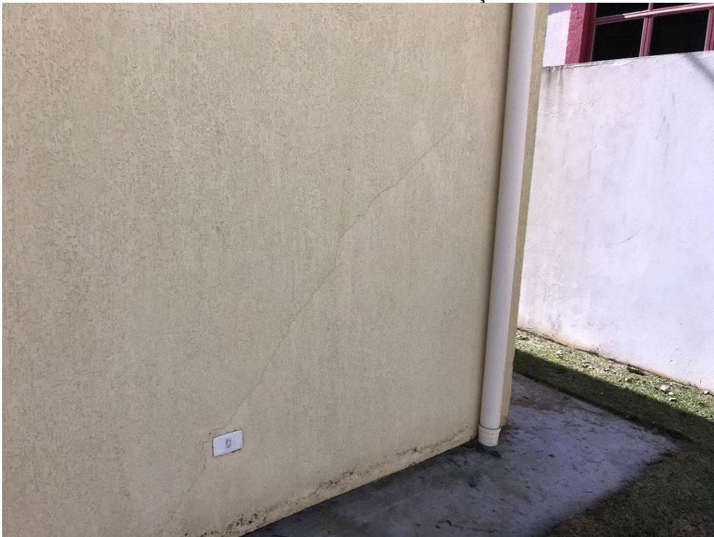
Foto 34 – Fissura em Parede – Situação atual.
