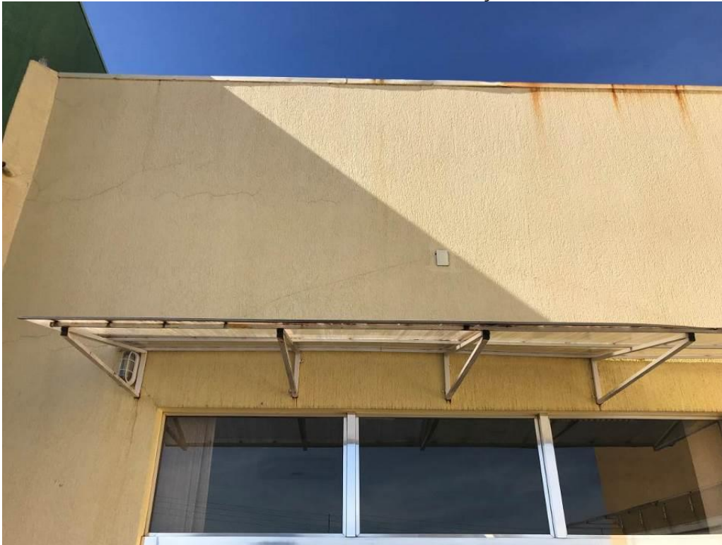
Foto 35 – Fissura em Parede – Situação atual.
