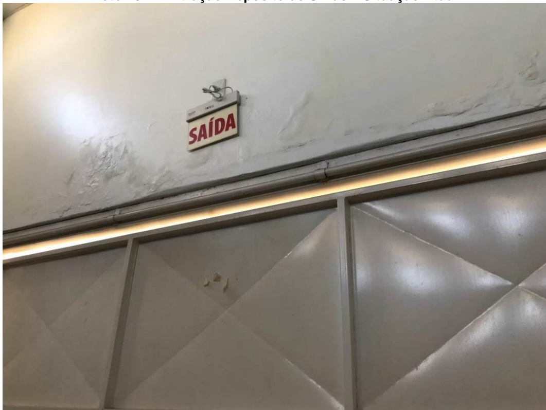
Foto 25 – Infiltração Depósito de Urnas – Situação Atual.
