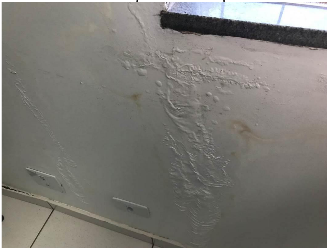
Foto 23 – Infiltração em Janela – Situação Atual.
