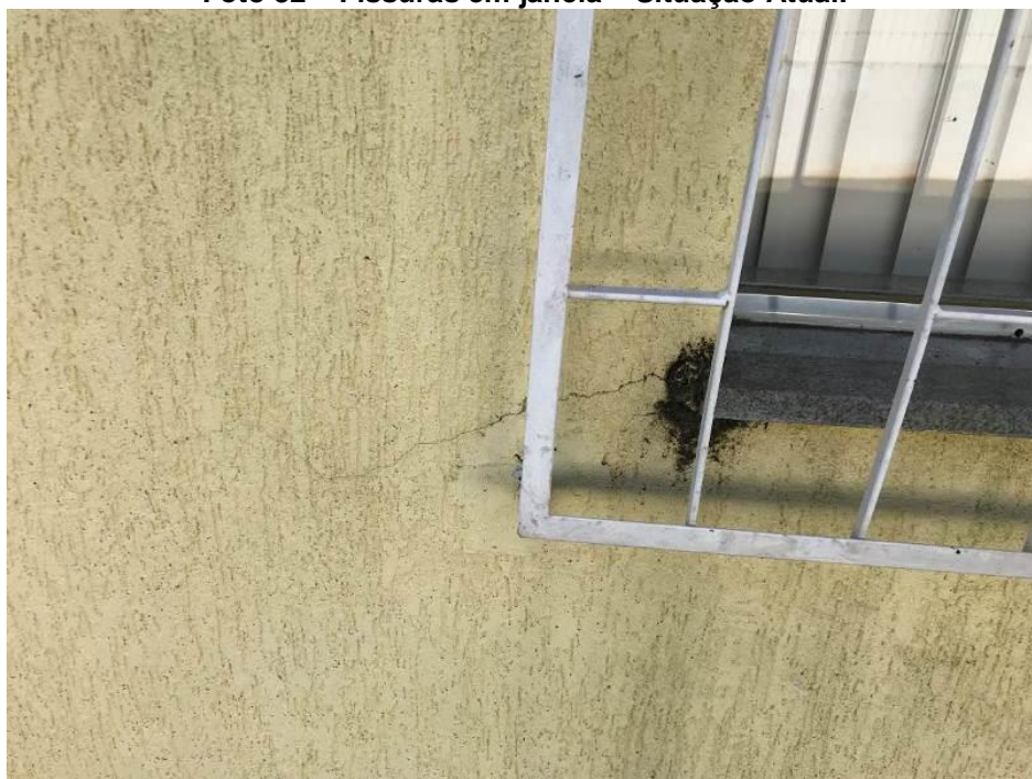
Foto 32 – Fissuras em janela – Situação Atual.
