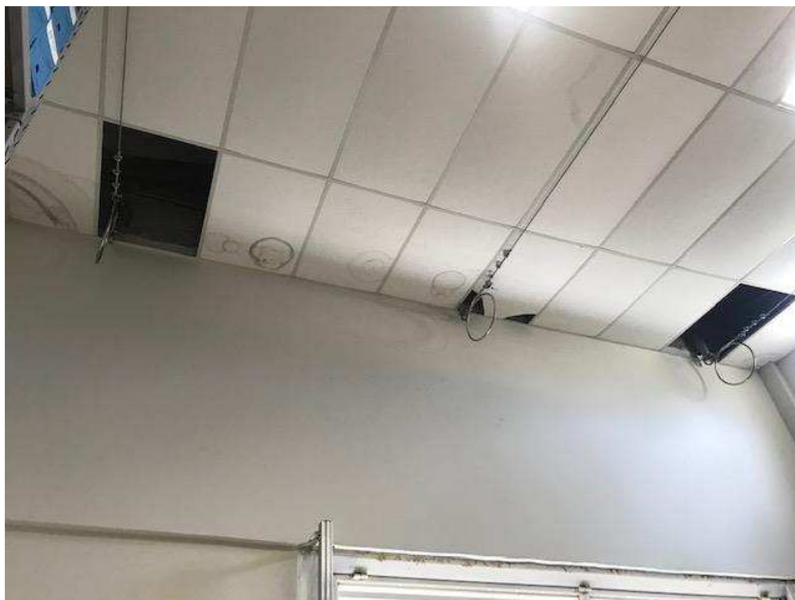
Imagem 14 – Instalação de ancoragens internas com suporte invertido, fixação em viga acima do forro.
