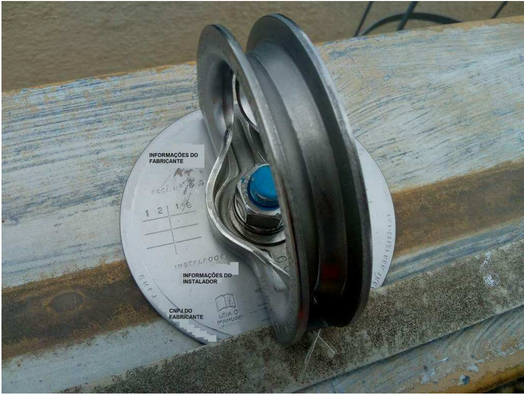
Imagem 15 - Disco de Identificação de Ponto de Ancoragem Instalado- Fórum Eleitoral de Piraquara
