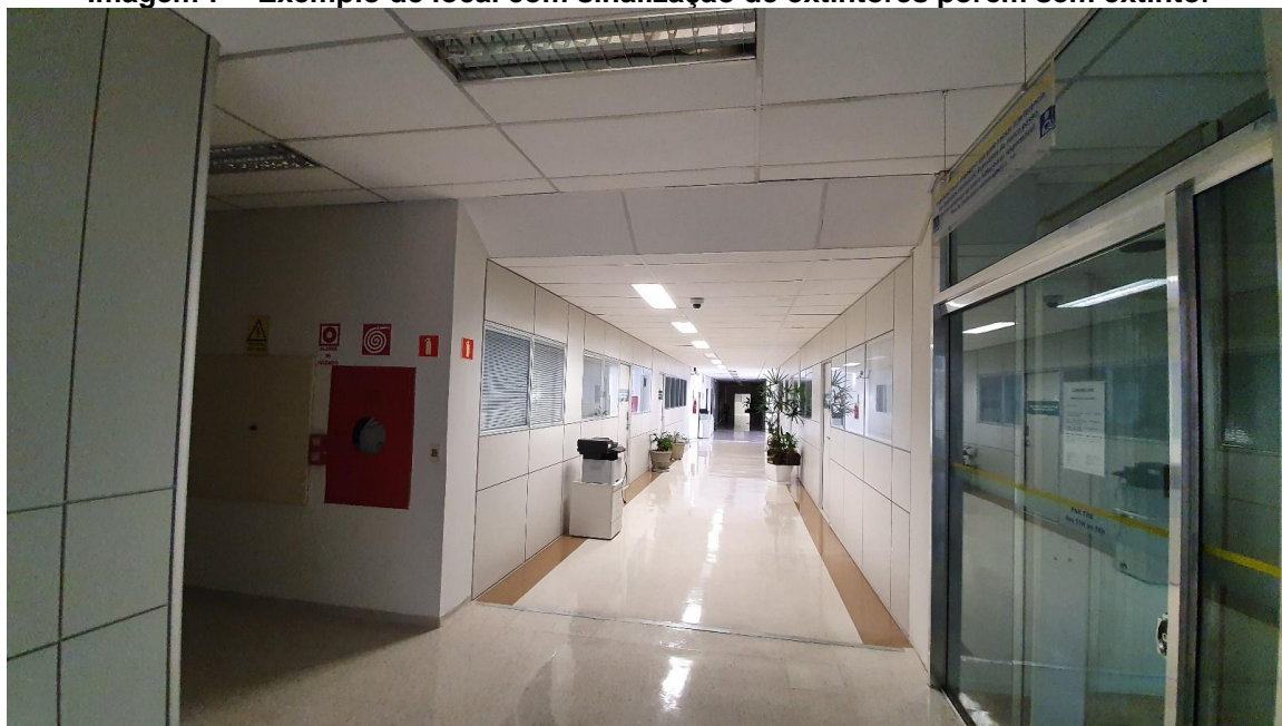
Imagem 7 – Exemplo de local com sinalização de extintores porém sem extintor
