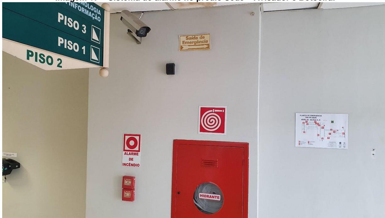
Imagem 17 – Sistema de alarme no prédio Sede – Avisador e Botoeira.
