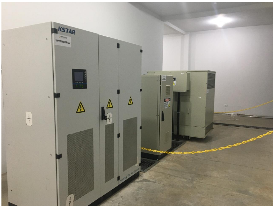
Figura 3: Conjunto Inversor e Transformador
