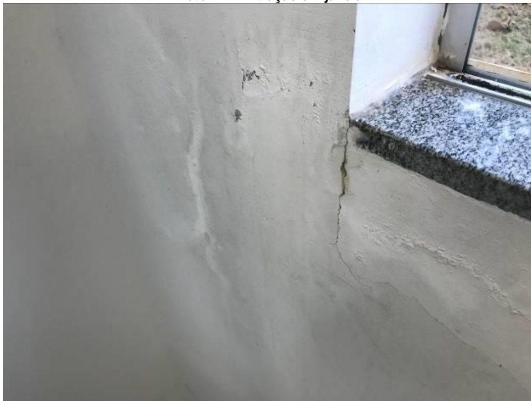
Foto 8 – Infiltração em janela
