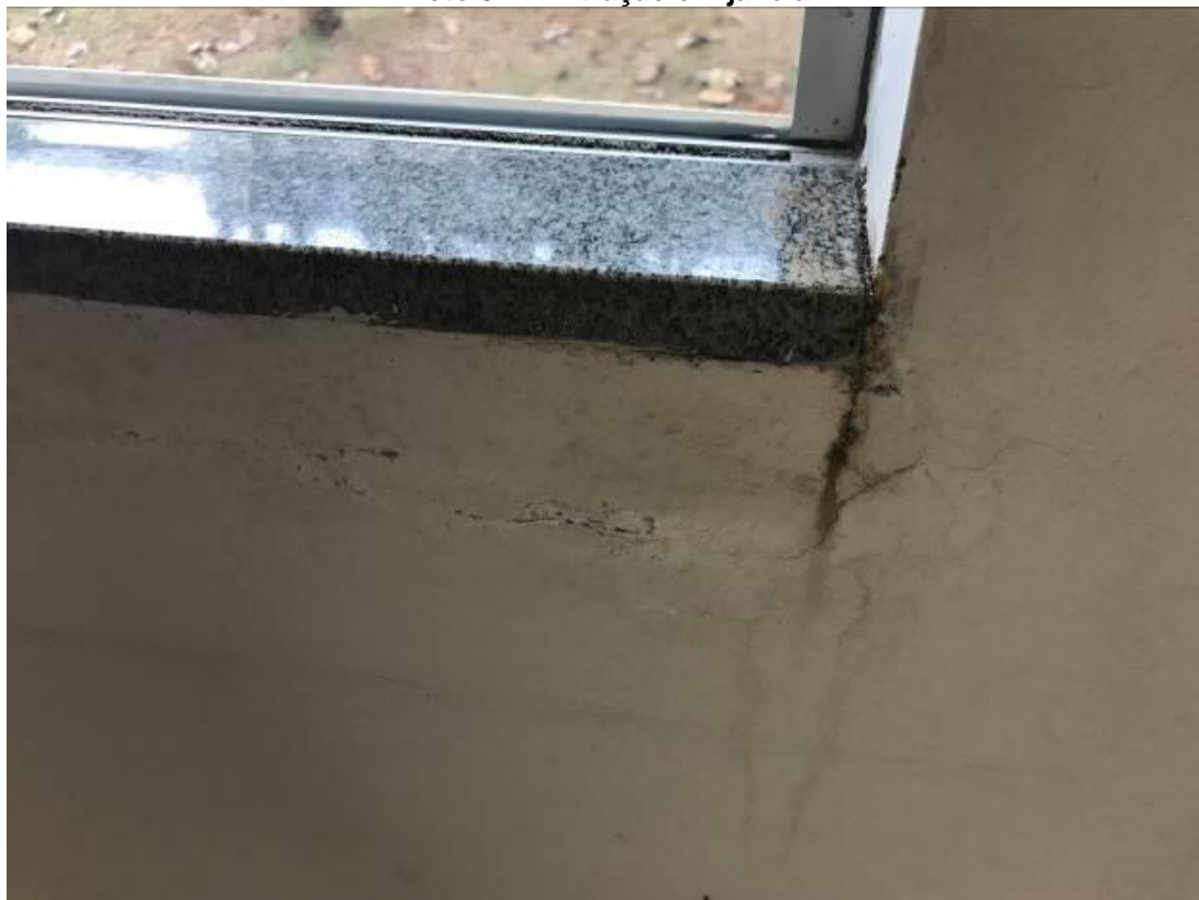
Foto 10 – Infiltração em janela
