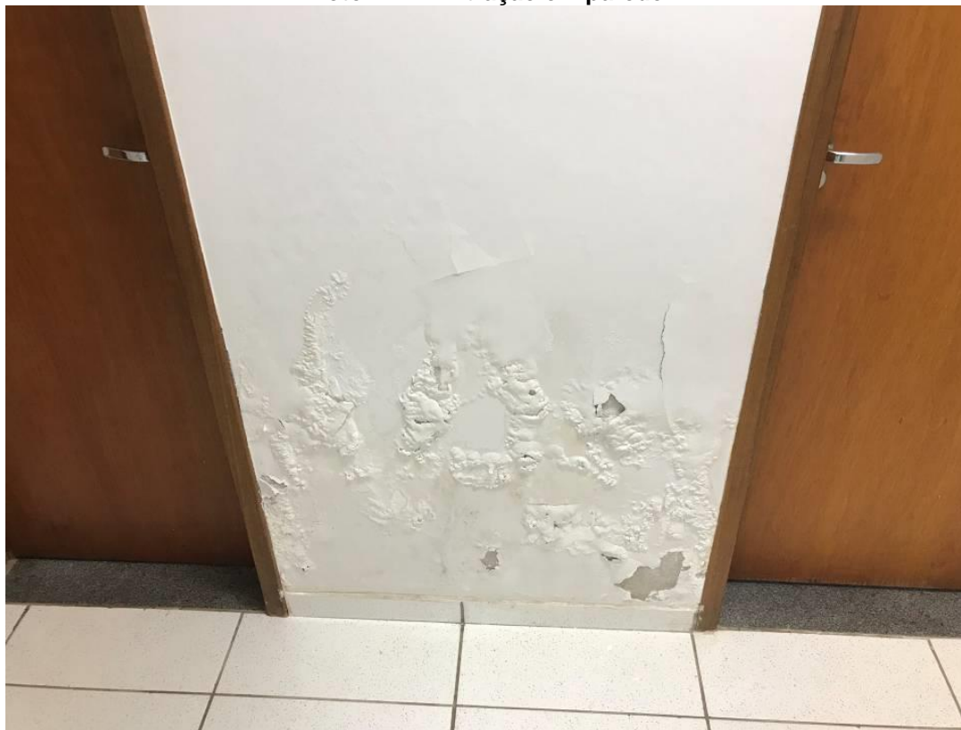
Foto 12 – Infiltração em parede
