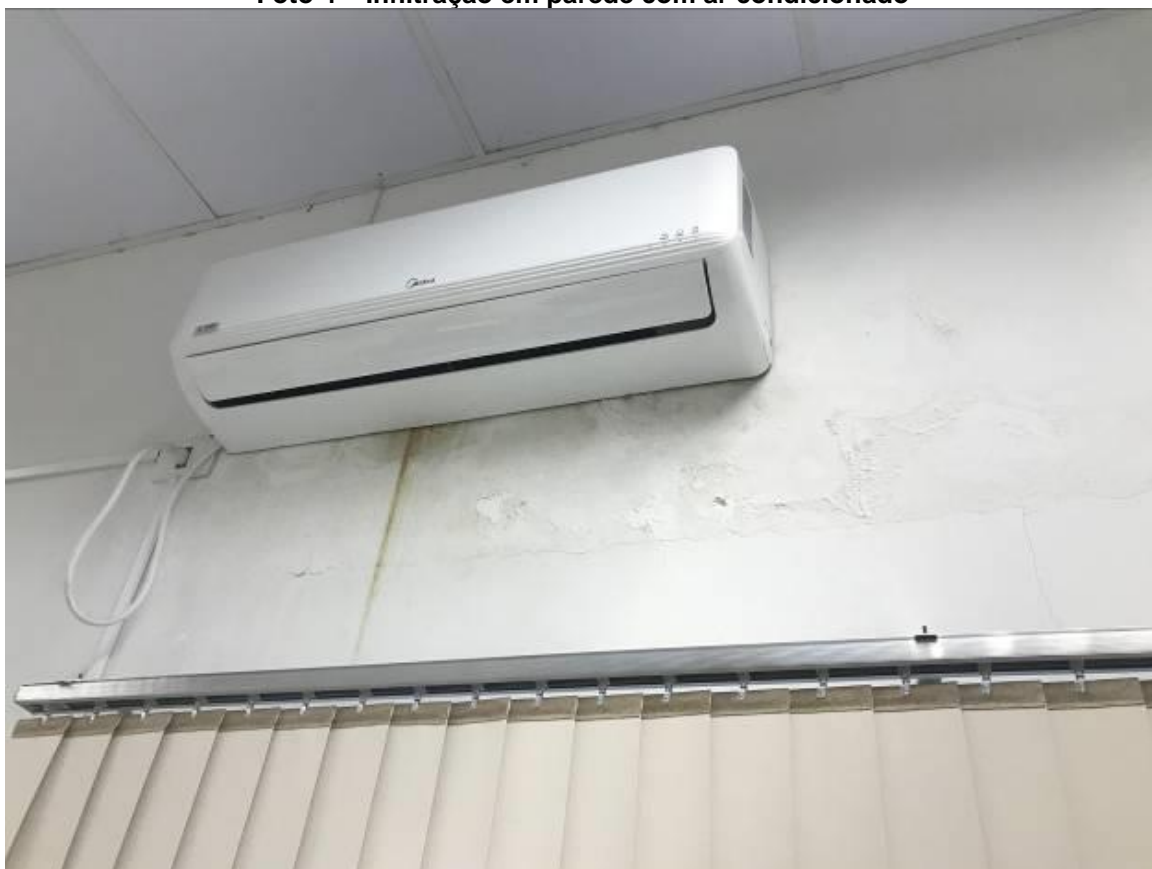
Foto 4 – Infiltração em parede com ar condicionado
