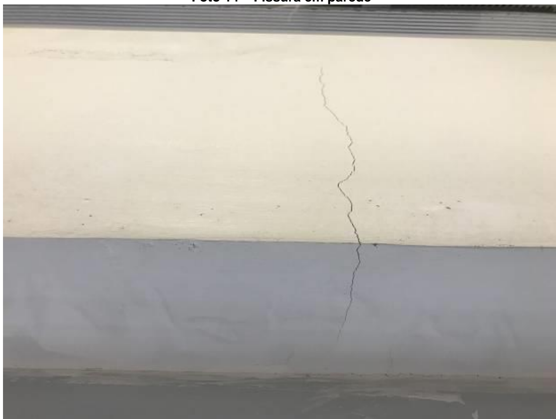
Foto 14 – Fissura em parede
