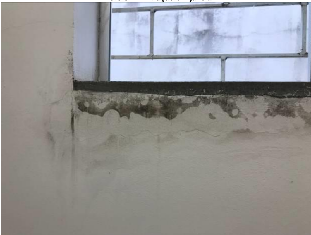
Foto 8 – Infiltração em janela
