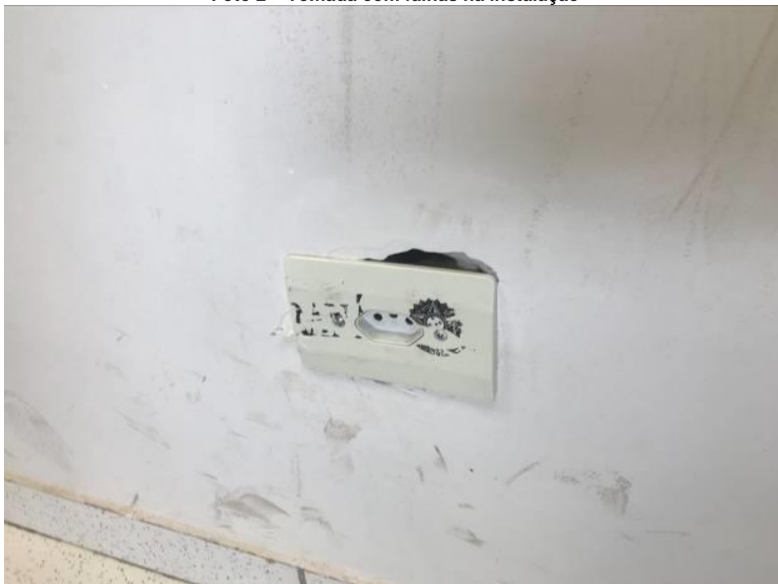
Foto 2 – Tomada com falhas na instalação
