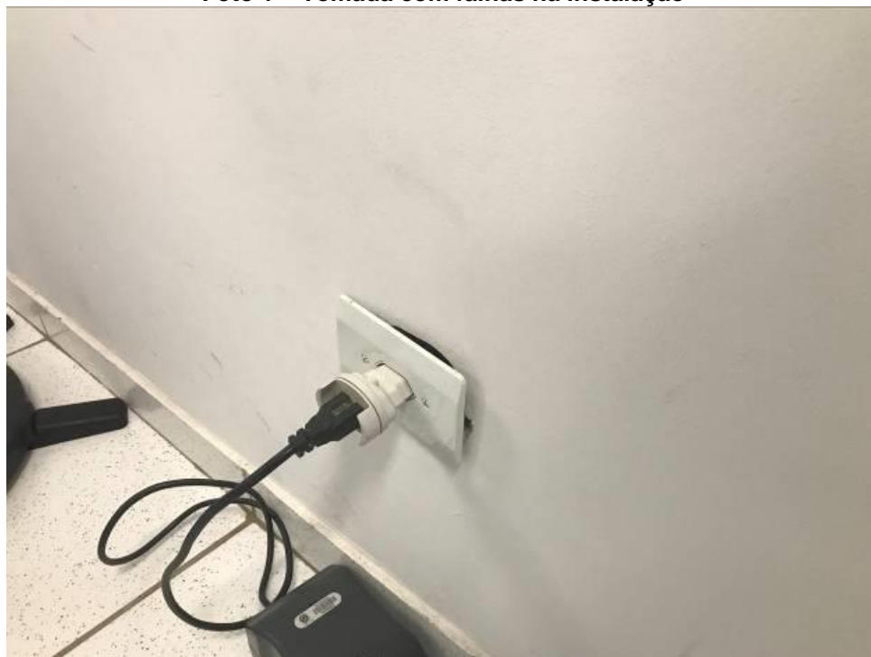
Foto 2 – Tomada com falhas na instalação
