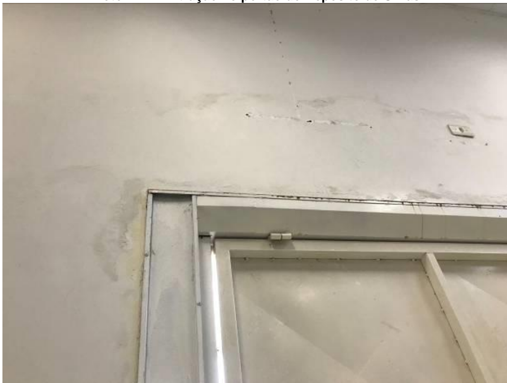
Foto 12 – Infiltração em parede
