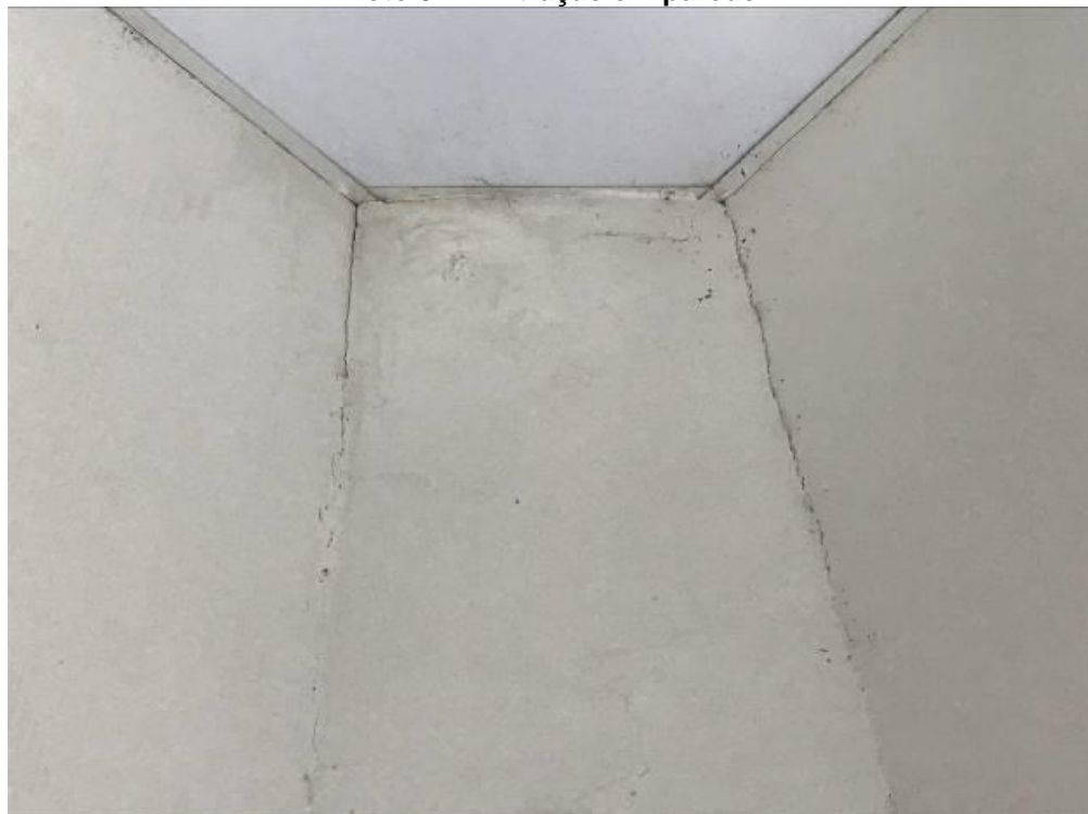
Foto 6 – Infiltração em janela
