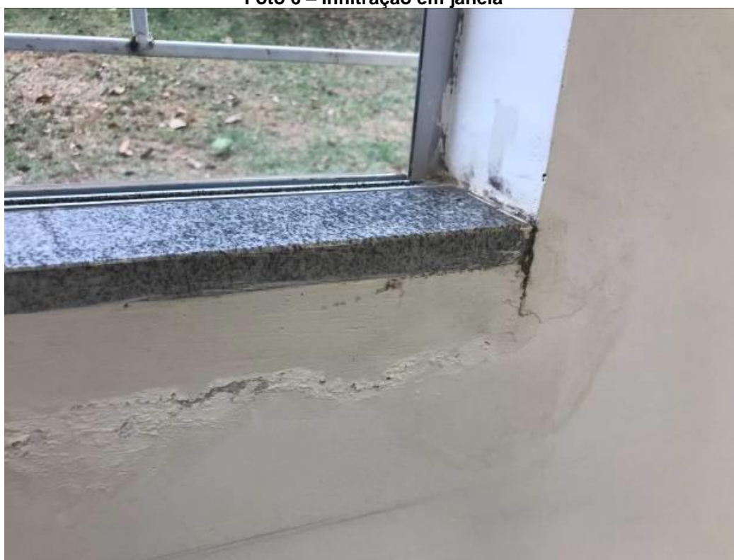
Foto 6 – Infiltração em janela
