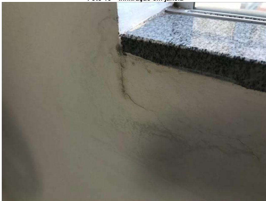
Foto 10 – Infiltração em janela
