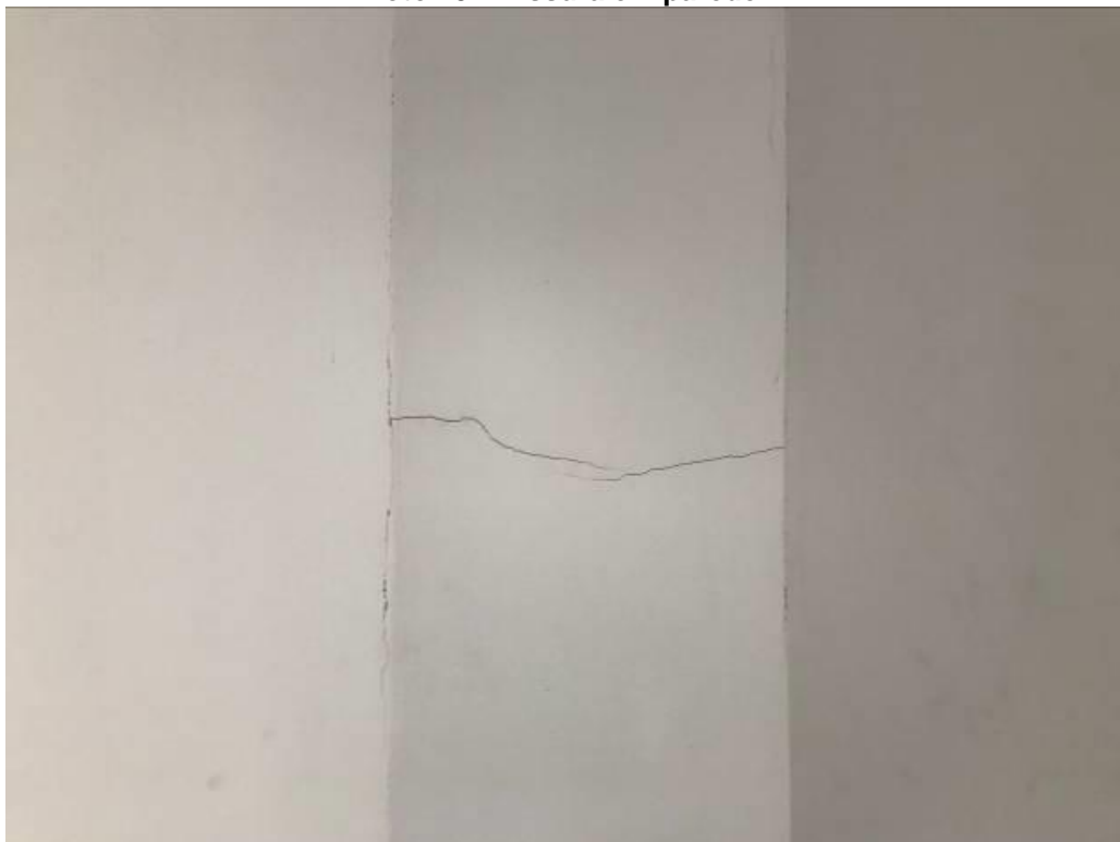
Foto 14 – Fissura em parede
