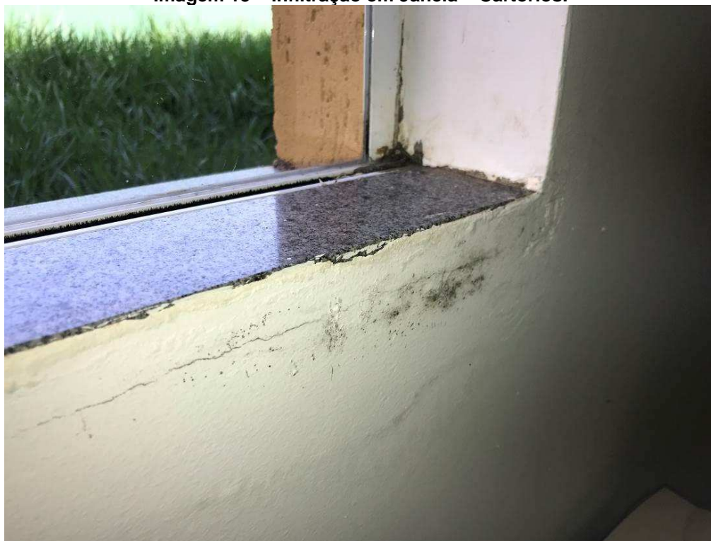
Imagem 15 – Infiltração em Janela – Cartórios.
