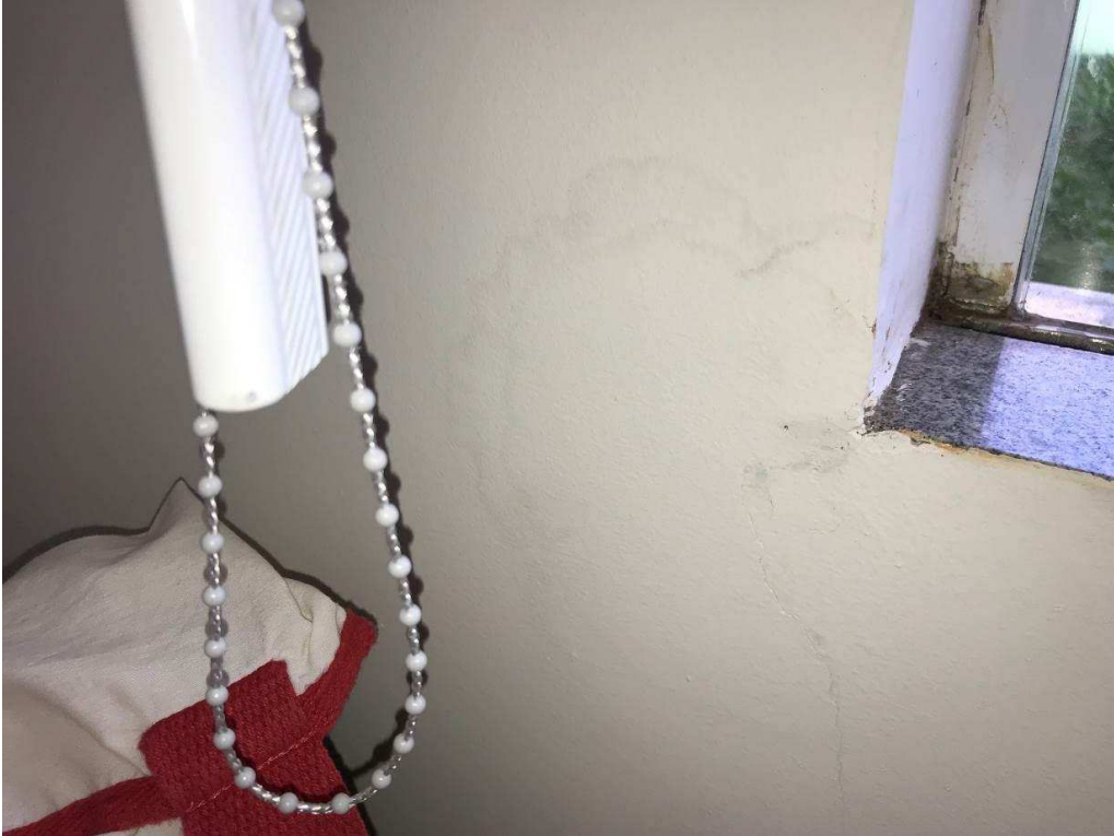
Foto 12 – Infiltração em Janela.
