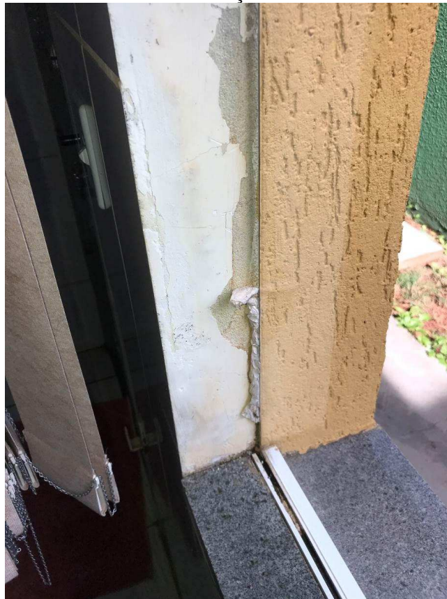
Foto 16 – Infiltração em Janela.
