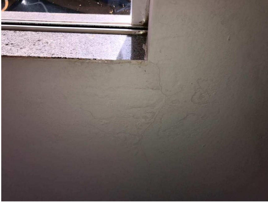
Foto 16 – Infiltração em Janela.
