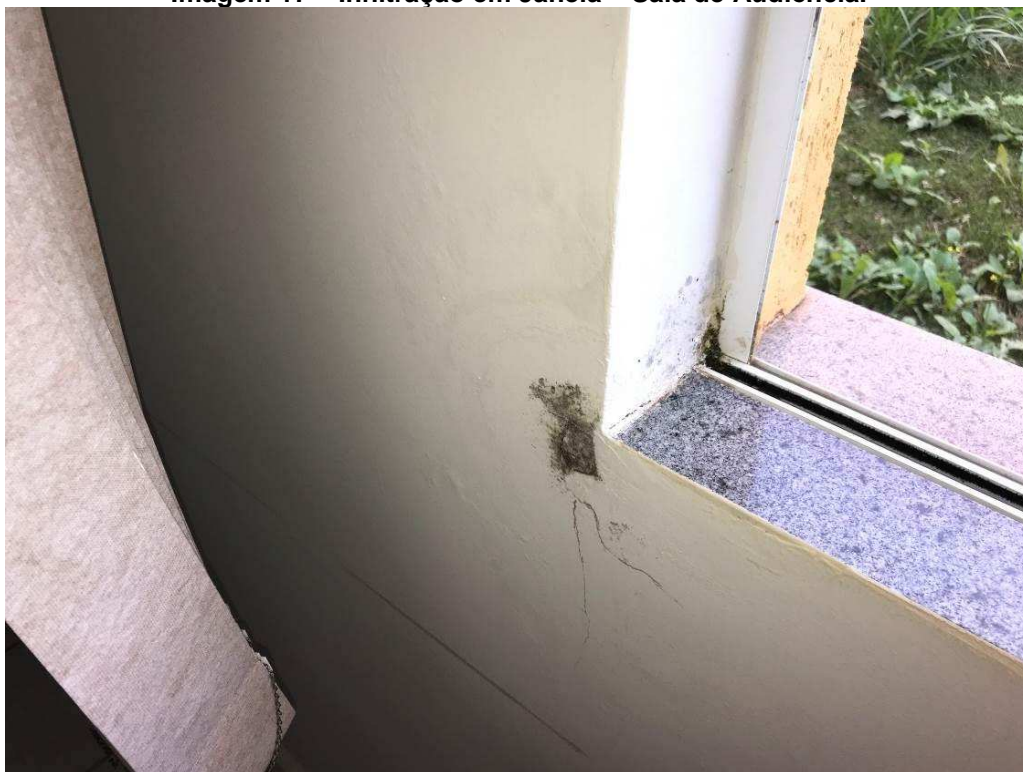
Imagem 17 – Infiltração em Janela – Sala de Audiência.
