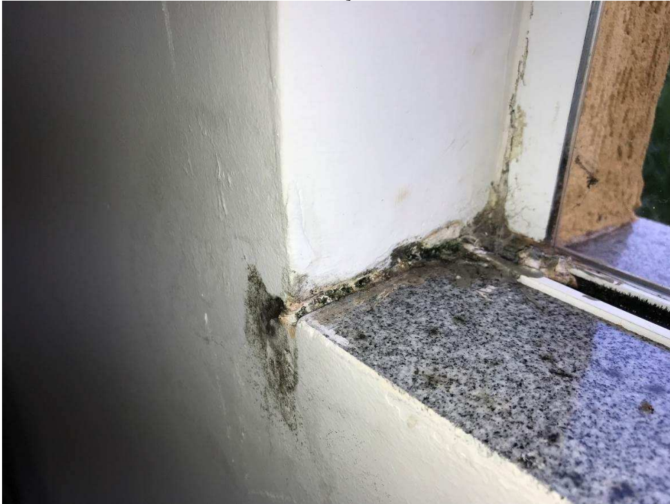
Foto 14 – Infiltração em Janela.
