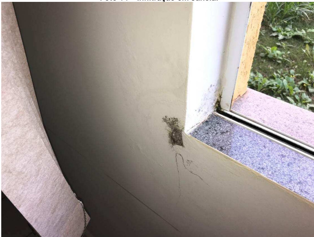
Foto 14 – Infiltração em Janela.
