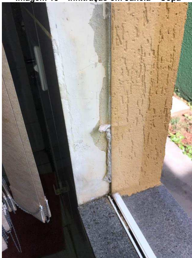
Imagem 19 – Infiltração em Janela – Copa
