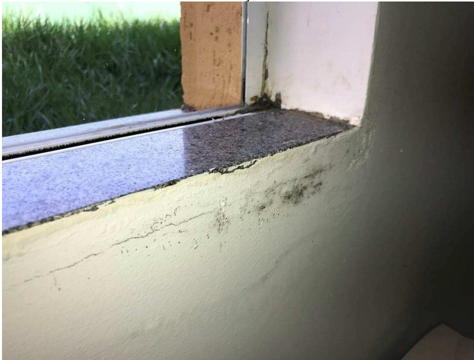
Foto 12 – Infiltração em Janela.
