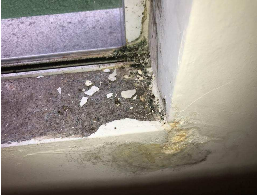
Foto 18 – Infiltração – Parede de Ar Condicionado.
