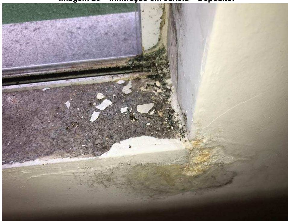
Imagem 20 – Infiltração em Janela – Depósito.
