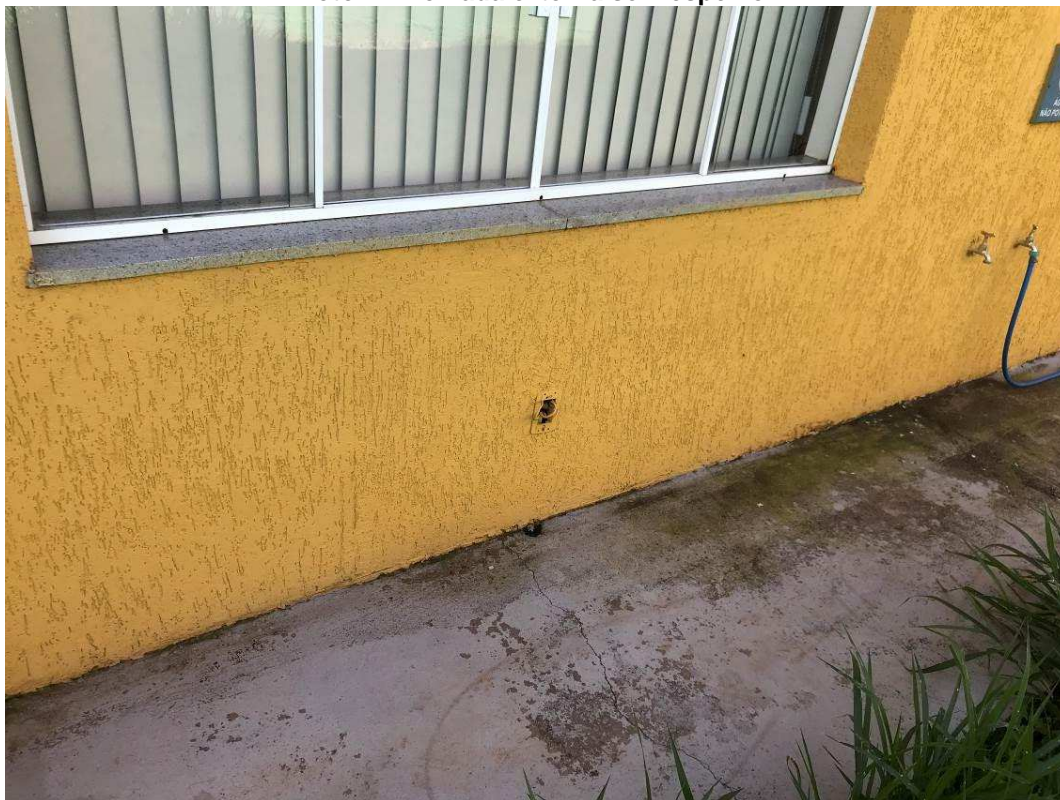
Foto 2 – Tomada Depósito sem espelho.
