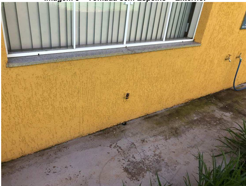
Imagem 3 – Tomada sem Espelho – Externo.
