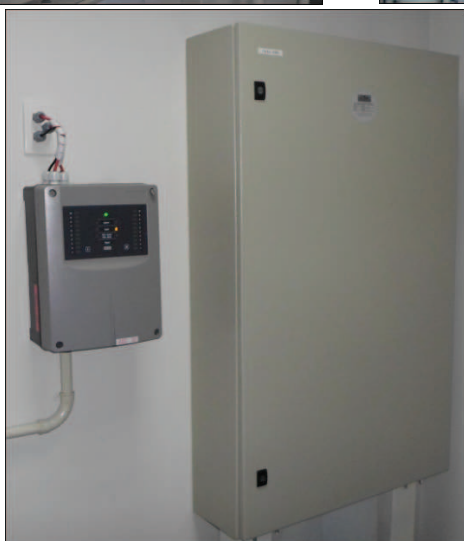
Foto 17 – QDG Seção de ADM Sistema
