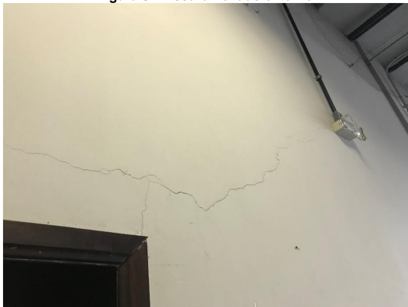
Figura 8 - Fissura no lado externo.
