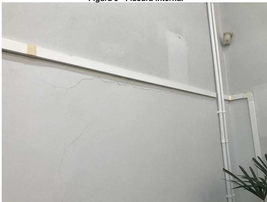
Figura 9 - Fissura interna.
