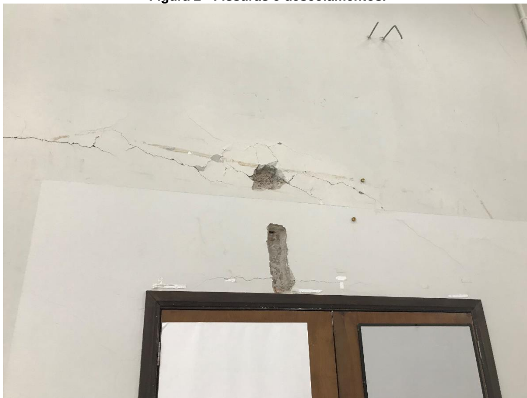
Figura 2 - Fissuras e descolamentos.
