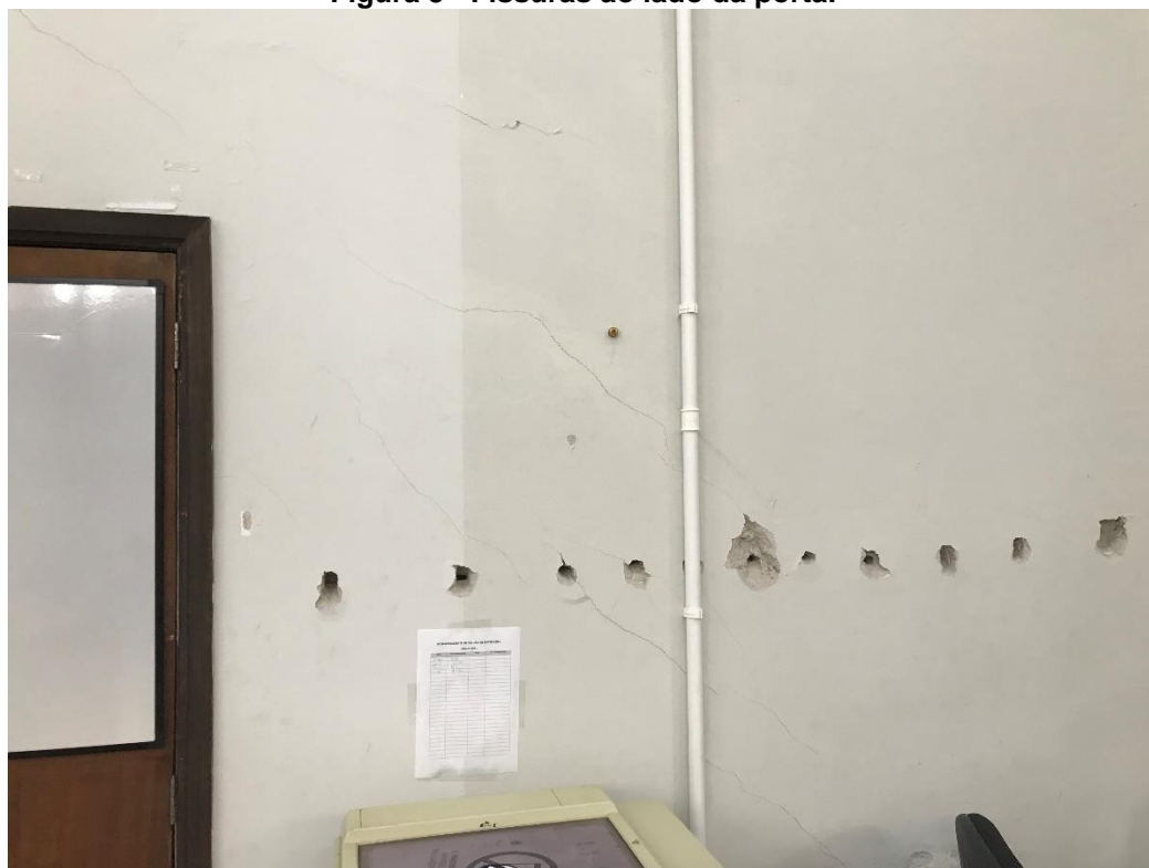
Figura 3 - Fissuras ao lado da porta.
